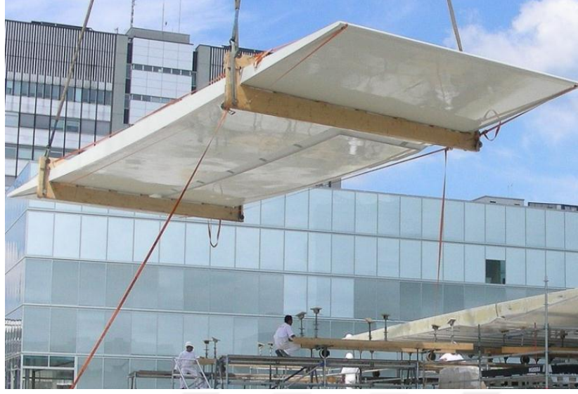
Şekil 7. Hafif sandviç çatı Keller ve ark. (2007)
