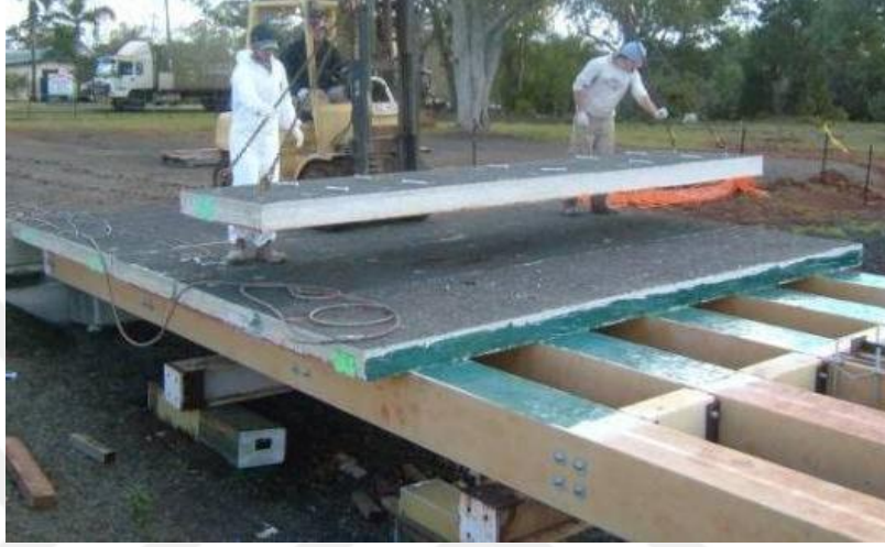
Şekil 6. Köprü yapımında kullanılan kompozit sandviç kiriş Manalo (2013)
