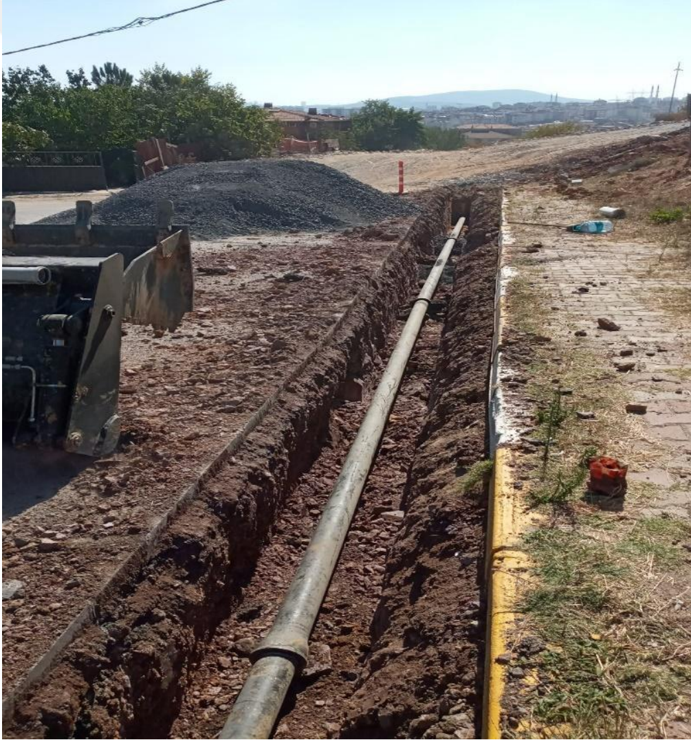
řekil 5. Dađıtım řebekesi ana boru hattı rnek grnt.
