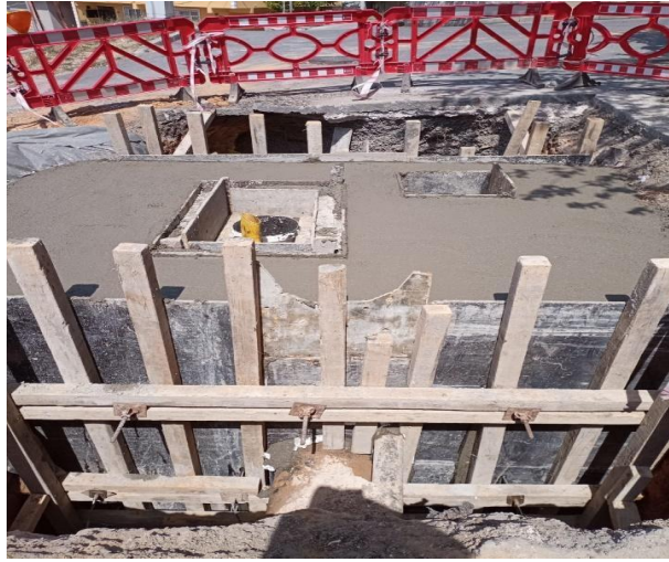
Şekil 41. İğneli vana odası imalatı
