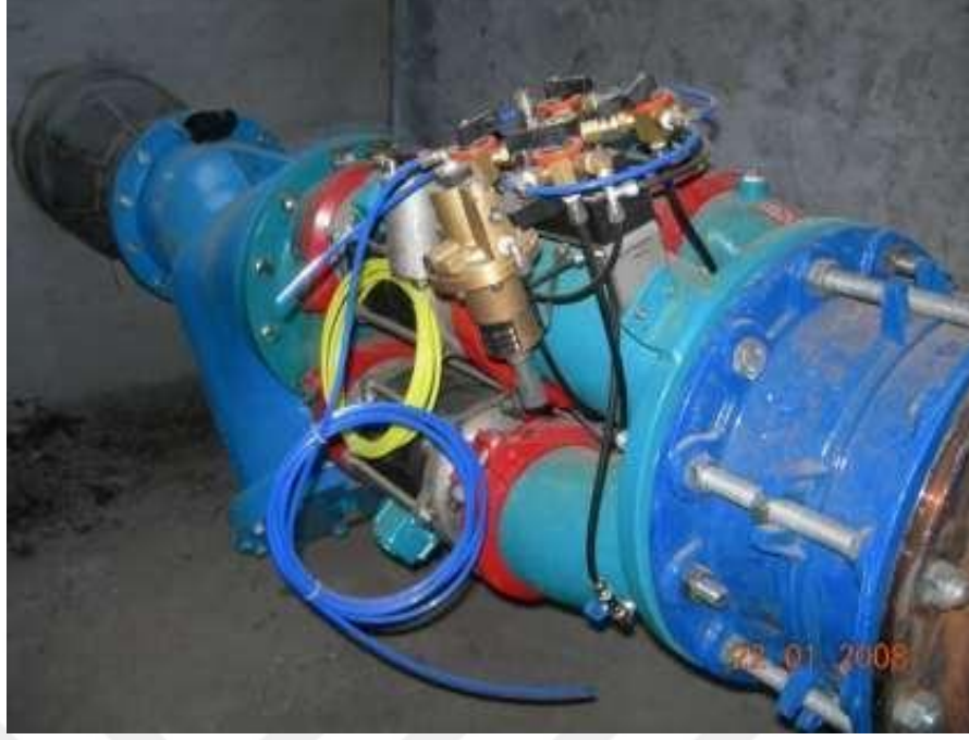
Şekil 14. Basınç kırıcı vana.
