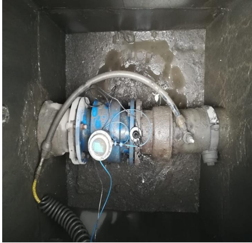
Şekil 37. Sultanbeyli’de debimetre odası
