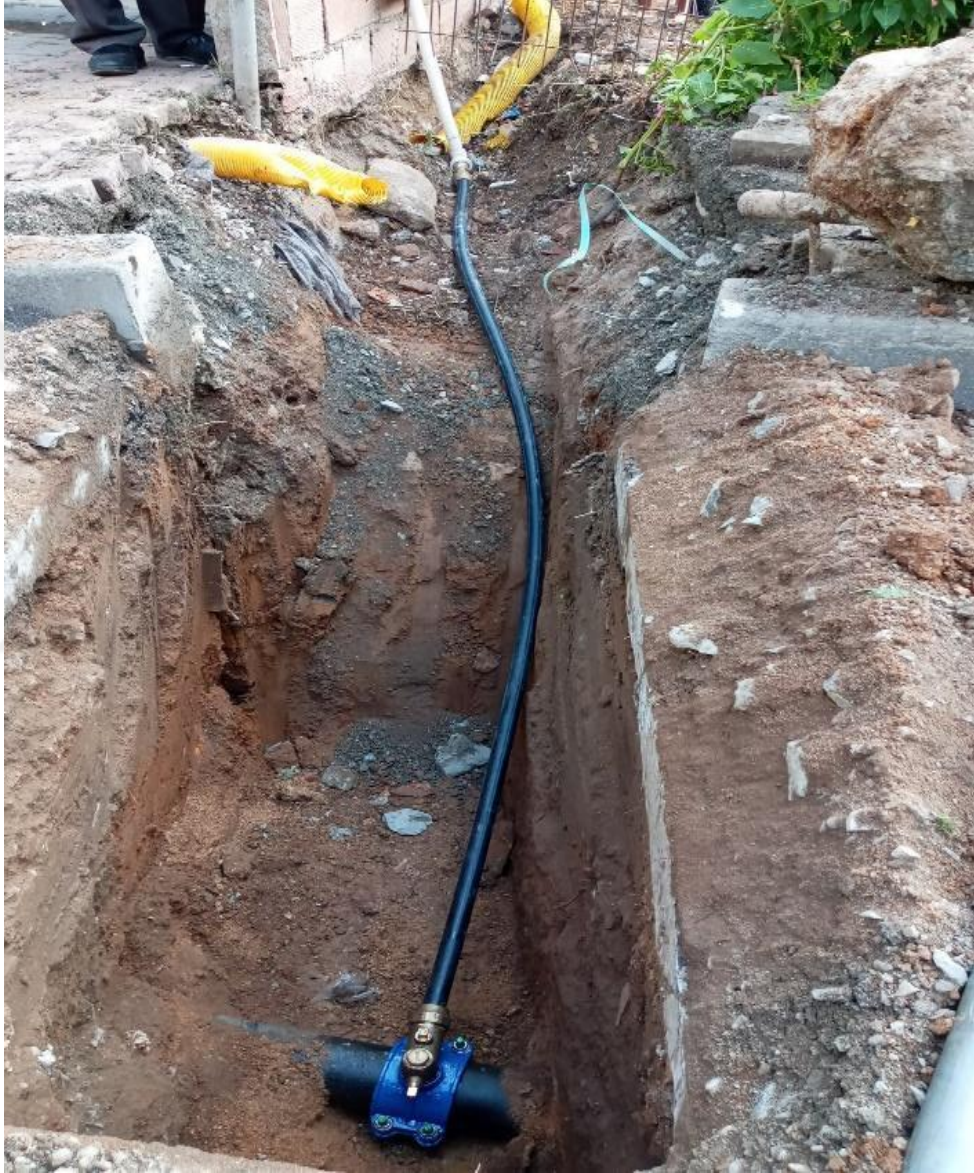
Şekil 6. Bina servis hattı örnek görüntü.
