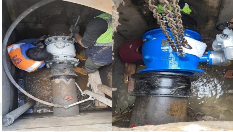
Şekil 42. İğneli vana ve debimetre imalatı
