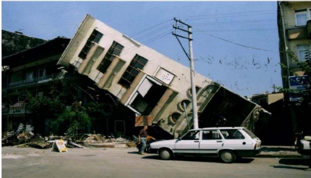
Şekil 15. 1999 Marmara depreminde Adapazarı zemin sıvılaşması sonrası yan yatan yapı.
