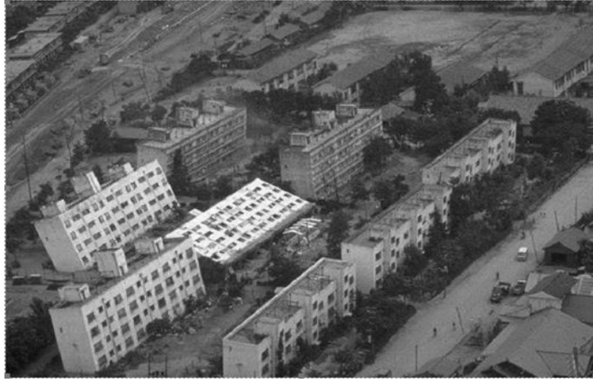
Şekil 16. 1964 Niigata depreminde zemin sıvılaşması sebebiyle yapıların zemine batması ve yan yatması. Kaynak: (Steinbrugge Collection, EERC, University of California, Berkeley).
