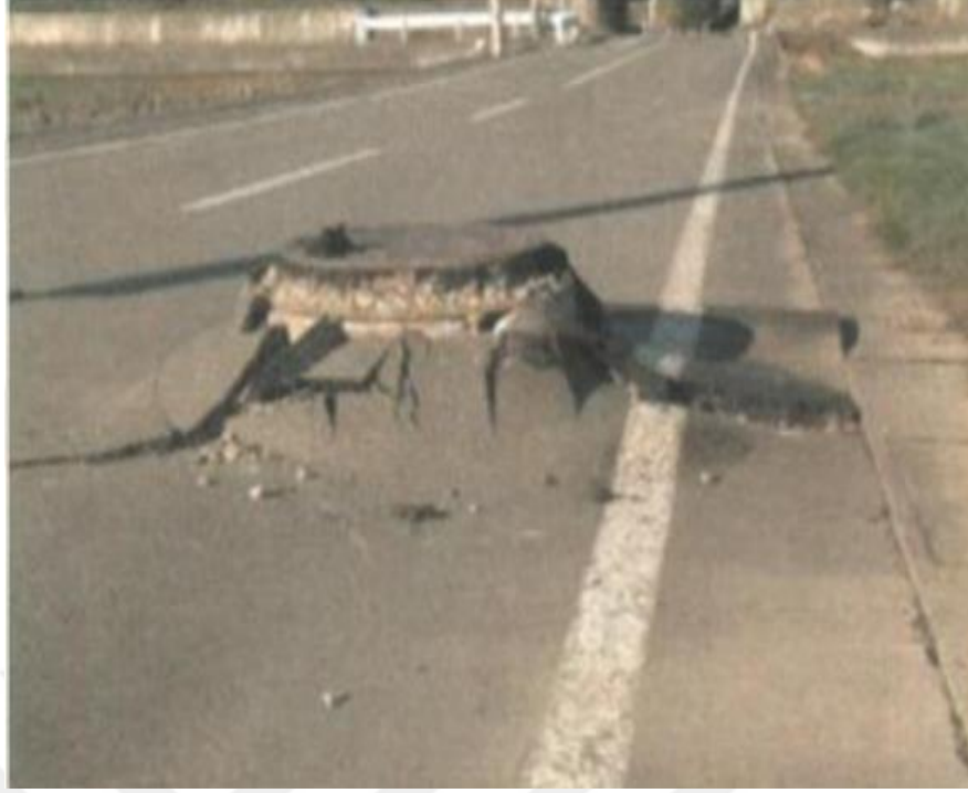
Şekil 18. 2004 Niğita Chuetsu depreminde zemin sıvılaşması sebebiyle meydana gelen muayene bacası yükselmesi.
