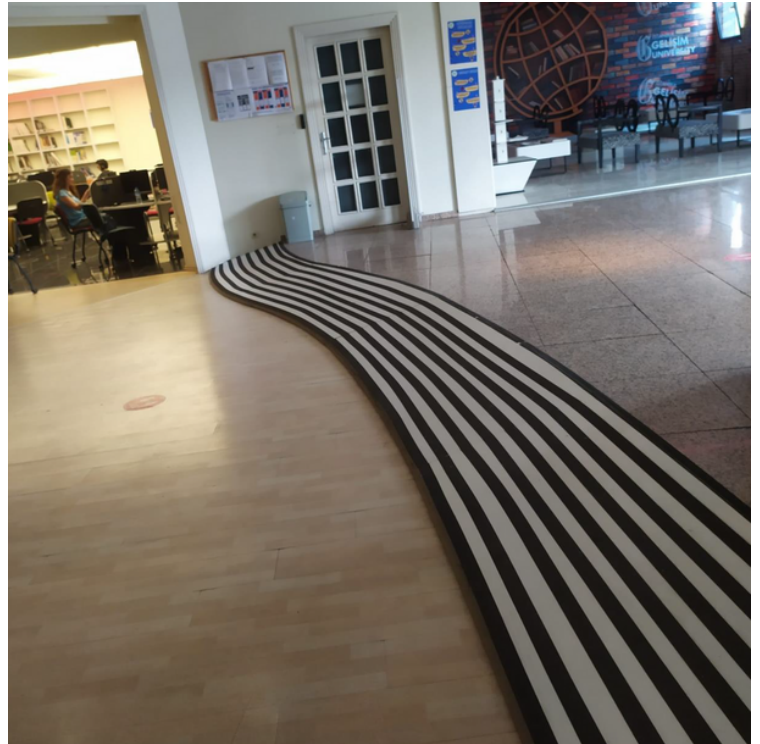
Görsel 22. Engelli Rampası
