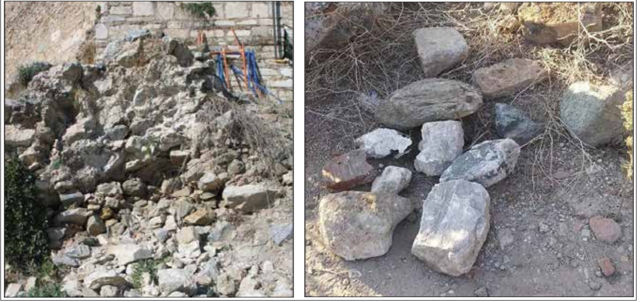
Levha 4. Mekanik testler için mahallinde alınmış olan duvar elemanları. / Elements taken from the wall for mechanical tests.
