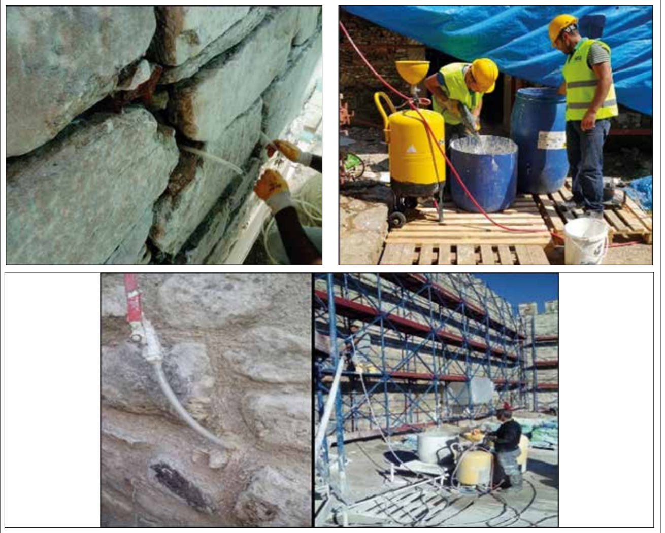
Levha 15: Enjeksiyon çalışmaları; ön hazırlık, harcın hazırlanması ve enjeksiyon uygulaması. / Grouting works; preliminary preparation, preparation of grout and application of injection
