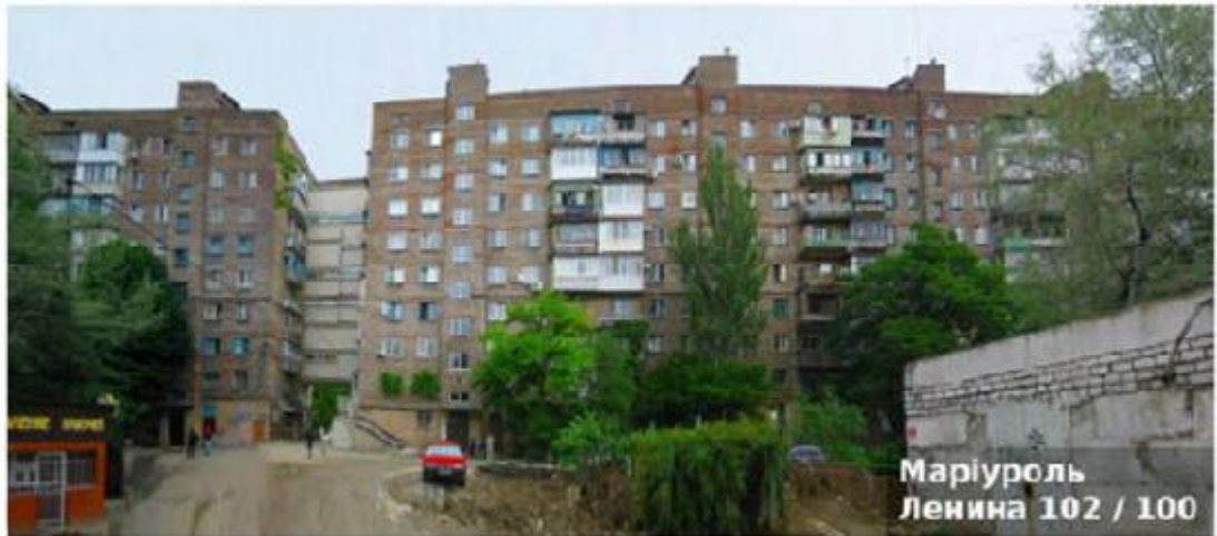
Şekil 2.5. Ukrayna'da geopolimer beton kullanılarak üretilmiş konut yapıları (Hardjito, 2005)
