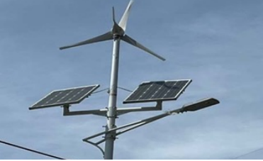
Görsel 7. Solar Güneş Enerjili ve Rüzgar Türbinli Sokak Aydınlatması
