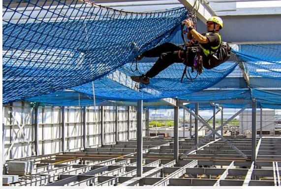
Şekil 55 Çatı İşlerinde Ağ Kullanımı
