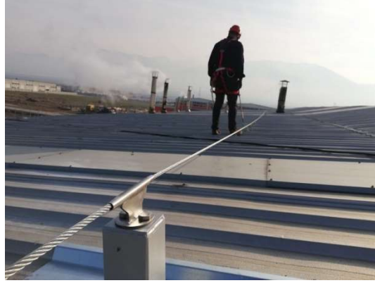
Şekil 43 Yatay Yaşam Hattı
