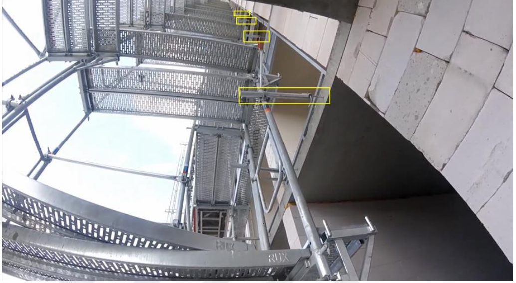
Şekil 43. İskelenin binaya ankrajlama uygulaması
