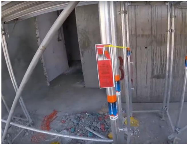
Şekil 46. İş güvenliği açısından kullanıma uygun olmayan, kırmızı etiketlenmiş iskele
