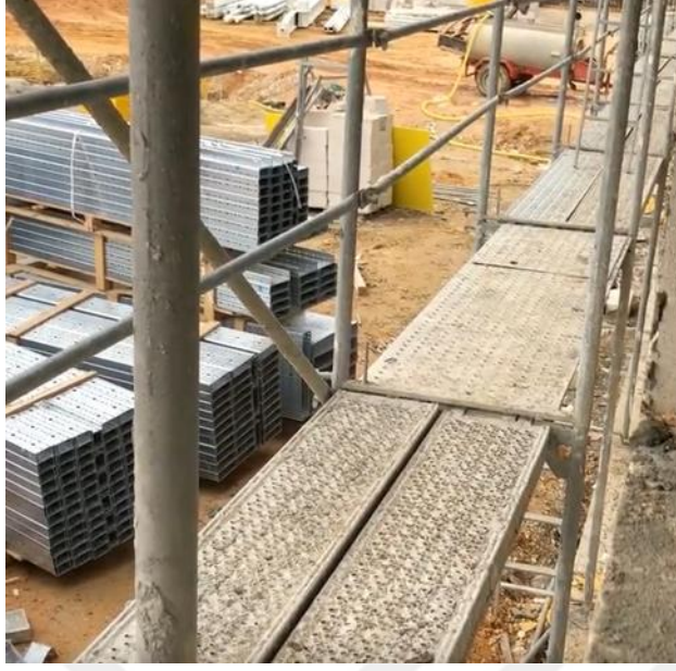
Şekil 54. İskele – yapı arasındaki mesafe
