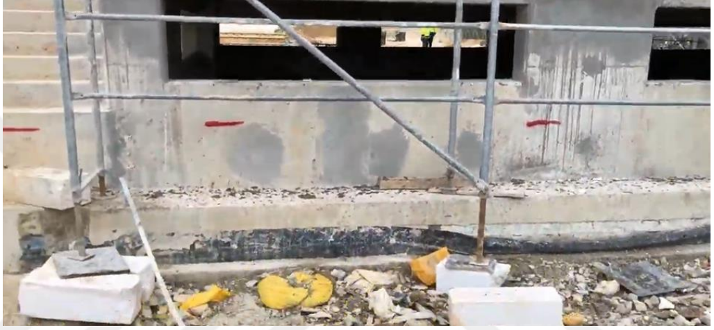
Şekil 53. Ayarlanabilir ayak mili ve taban plakası altında uygunsuz altlık kullanımı
