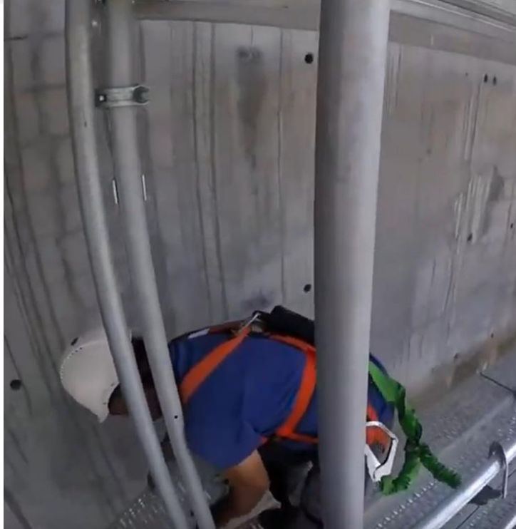
Şekil 50. Paraşüt tipi emniyet kemeri kullanarak çalışma
