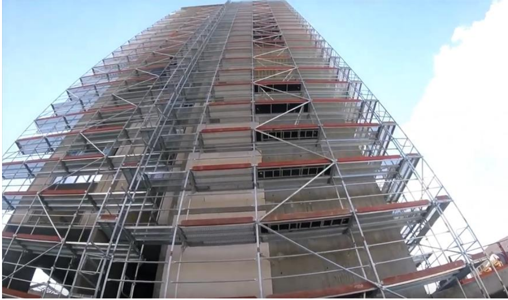
Şekil 42. Çapraz bağlantılar, korkuluk ve her katta merdiven uygulamaları
