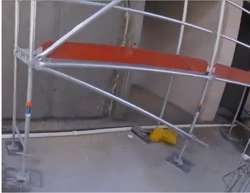
Şekil 44. Taban plakası, taban altlığı ve ayarlanabilir ayak mili kullanımı
