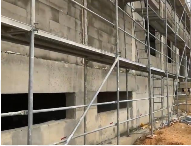
Şekil 51. İskele içi merdiven kullanımı
