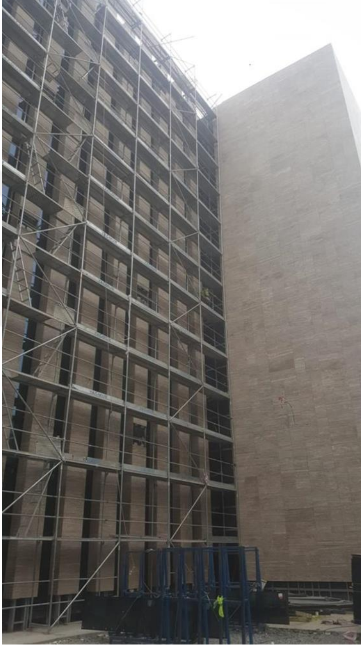
Şekil 57. İskele merdivenleri, korkuluk sistemleri ve çapraz elemanlar uygulamaları Şantiye içindeki cephe iskelelerinin korkuluk sistemlerinde; ana korkuluklar, ara korkuluklar, yan-ara sonlandırma elemanları ve topuk levhaları yer almaktadır. Çapraz
