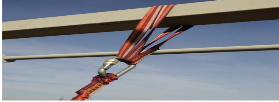
Sağlam noktalara sarılmış perlonla Hazırlanmış ankraj noktası
