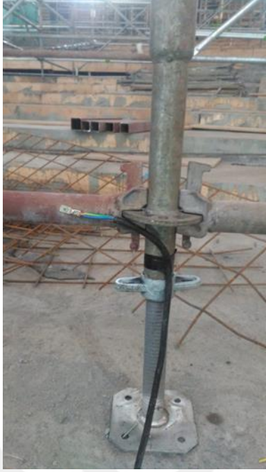
Şekil 59. Taban plakası ve ayarlanabilir ayak mili
