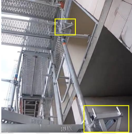
Şekil 45. İskele-yapı arasındaki mesafe için iskele-konsol sistemi kullanımı
