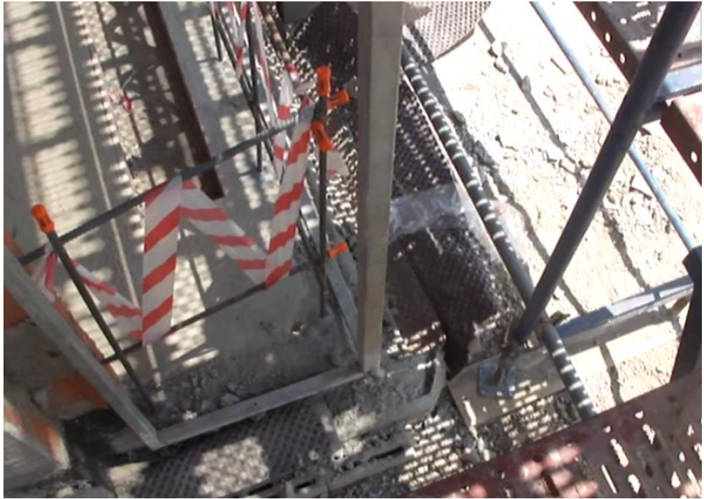
Şekil 34. Taban plakası, plaka altlığı ve ayarlanabilir ayak mili kullanımı
