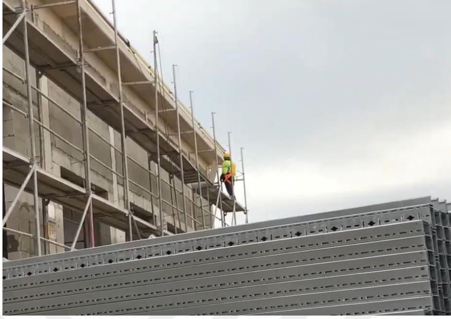
Şekil 56. Tam vücut tipi emniyet kemeri ile güvenli çalışma
