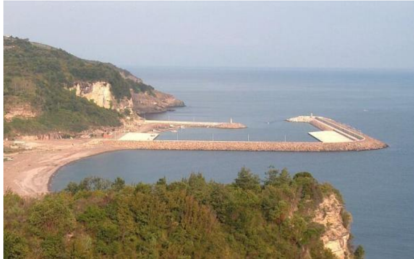
Resim 8. İlyasbey Balıkçı Barınağının mevcut yapısı.
