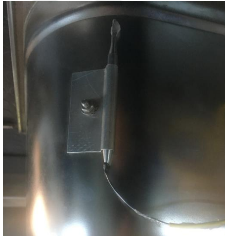
Şekil 6.23. Termostat ucu tank üzeri montajı
