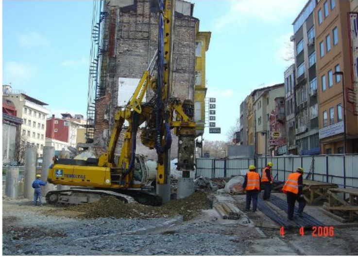
Resim 2.1. Yerinde dökme beton kazık (fore) uygulaması
