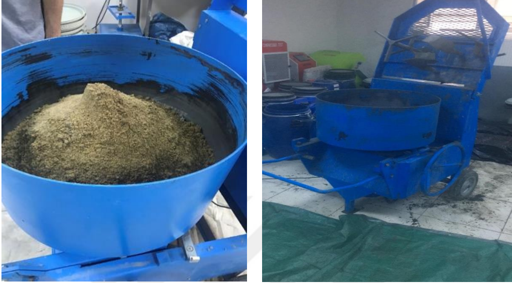
Şekil 3.7. Beton döküm aşamaları
