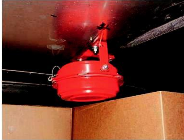
Resim-7 Konteyner İçi Yangın Söndürme Sistemi 56
