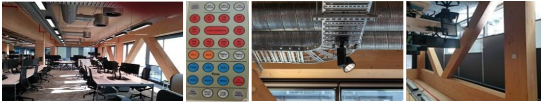
Şekil 28. Aurecon Brisbane ‘deki açık planlı ofisten iç mekân görünümü ve aydınlık düzeyini ayarlamak için kullanılan uzaktan kontrol cihazı (solda) (Gentile, 2022), Tavanda kablo tavaasına monteli spot aydınlatma (orta) (Aurecongroup), Ofiste doğal aydınlatma kontrolü için kullanılan gölgeleme elemanı (sağda) (Kieu Pham, 2022).
