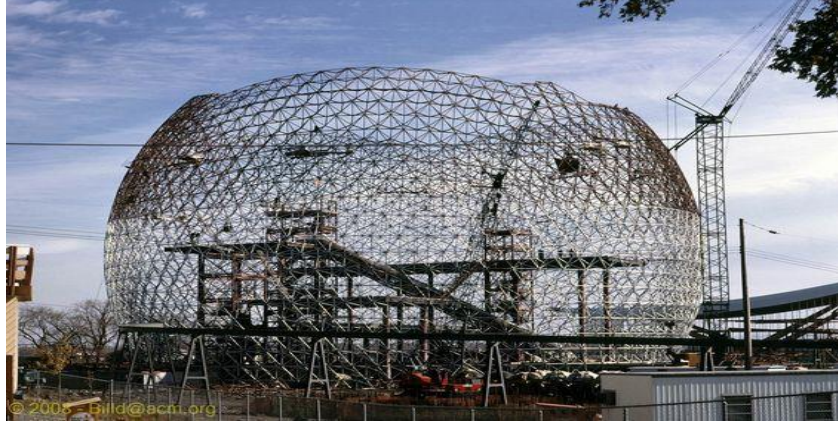
Şekil 44. Singapur Spor Merkezi'nin inşaat durumdaki tamamlanmamış hali Kaynak: Chia J ve Abd Rahman N A, (2006)
