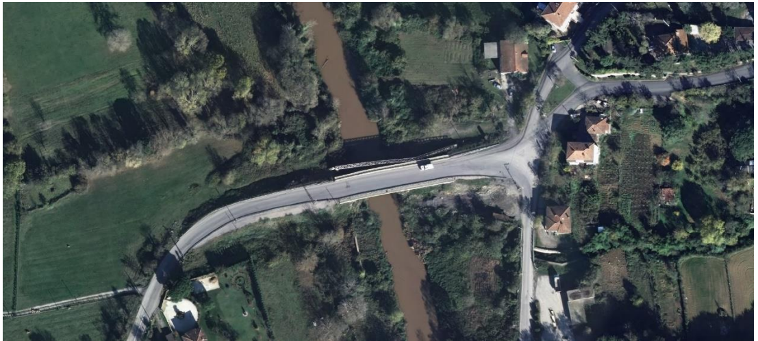
Şekil 11. K2 köprüsü uydu görüntüsü.
