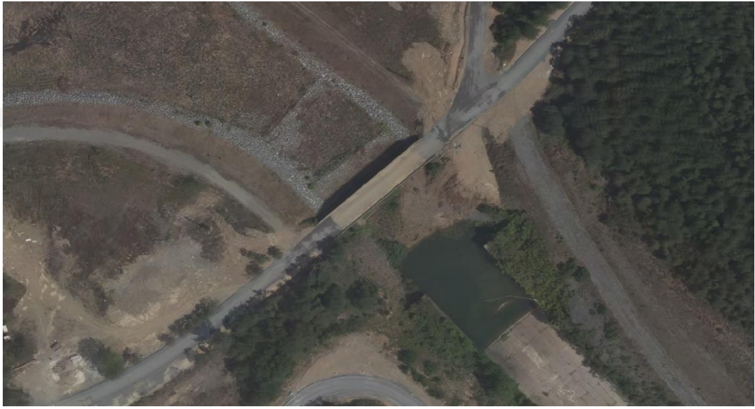
Şekil 18. K9 köprüsü uydu görüntüsü.
