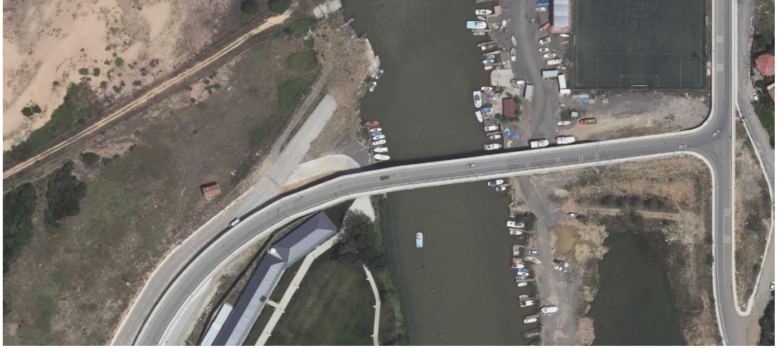
Şekil 10. K1 köprüsü uydu görüntüsü.
