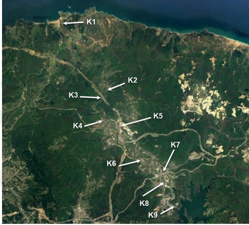
Şekil 9. Ömerli barajı mansabındaki köprüler.
