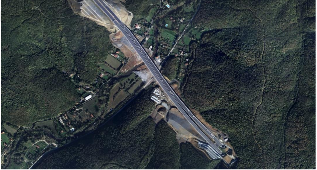
Şekil 12. K3 köprüsü uydu görüntüsü.
