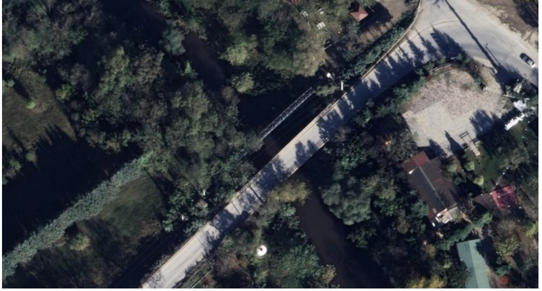
Şekil 13. K4 köprüsü uydu görüntüsü.
