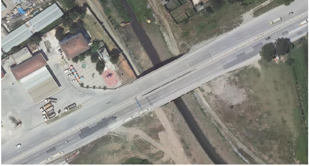
Şekil 16. K7 köprüsü uydu görüntüsü.
