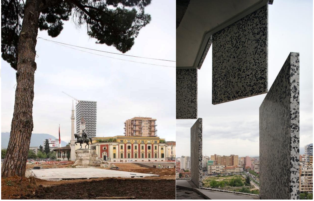
Şekil 46: (sağ) TID kulesinin cephesinde kullanılan doğal taş panelleri. (URL 38)
