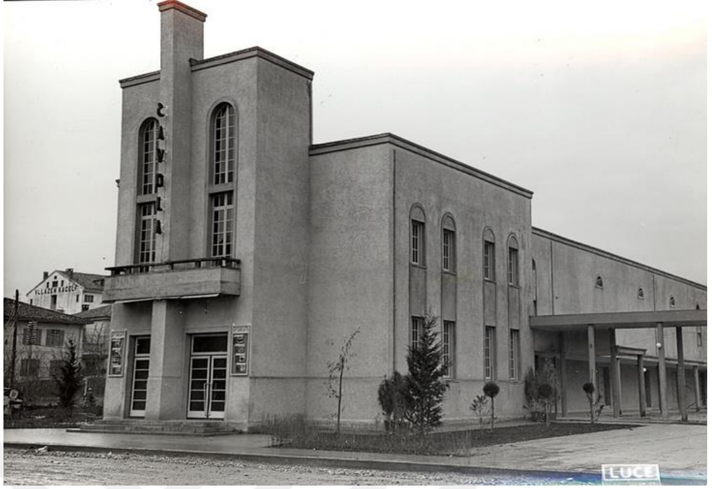
Şekil 97: Arnavutluk Ulusal Tiyatrosu binası, inşaatın ilk zamanları. (URL 64)
