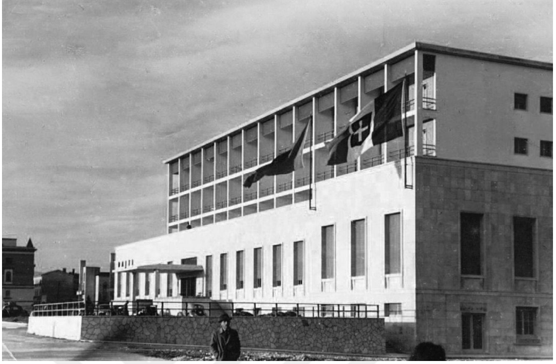
Şekil 100: Önünde İtalyan bayrağı bulunan Dajti Oteli inşaat sonrası. (URL 67)
