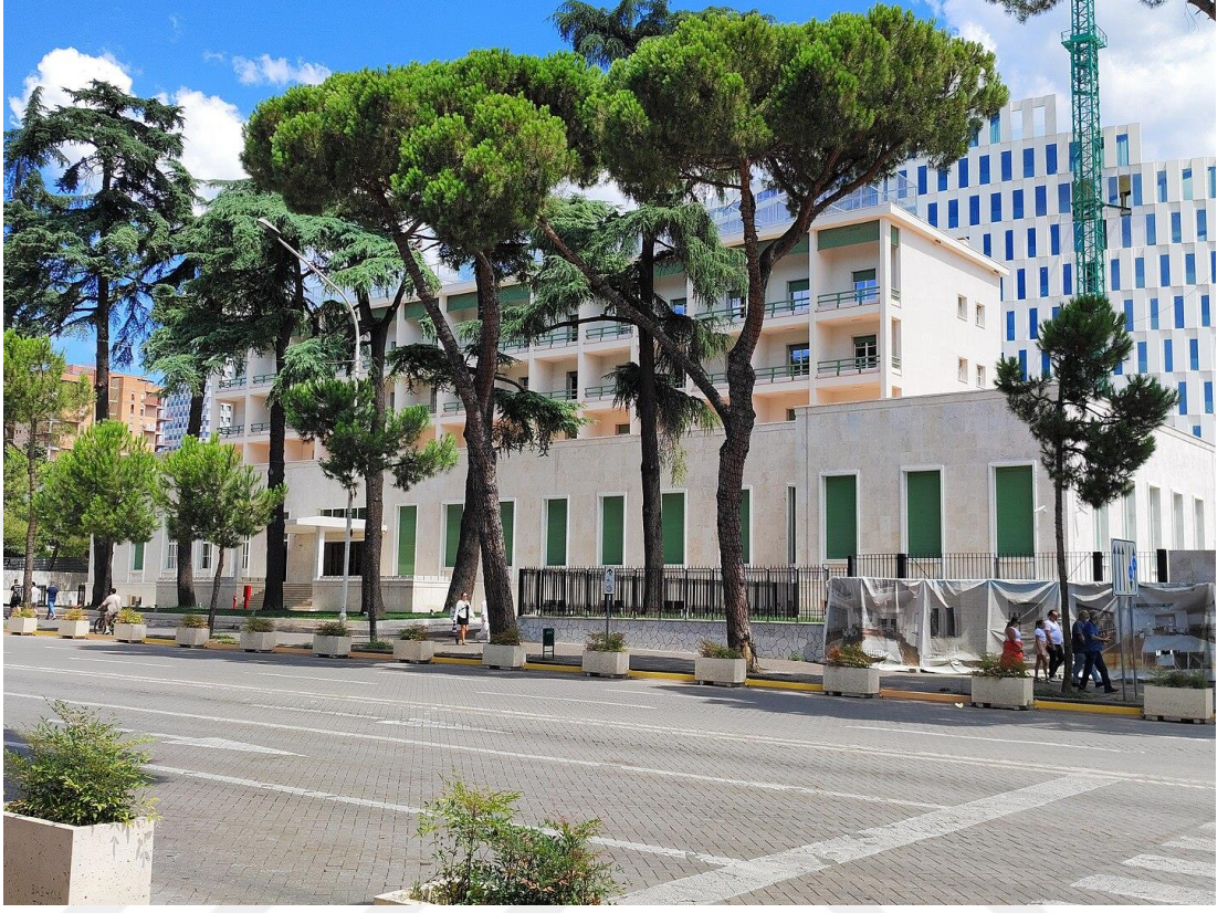
Şekil 103: Arnavutluk Bankası'nın yeni Genel Merkezi olarak yenilenen Hotel Dajti binası. (URL 70)
