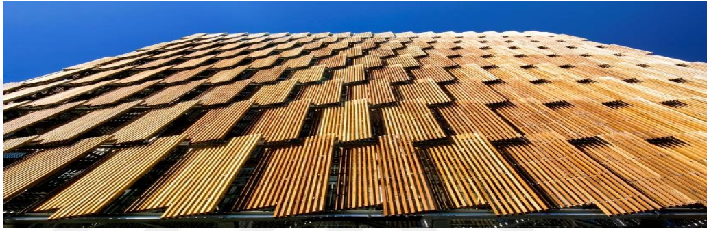
Şekil 44. CH2 Binasının Dış Cephesi (Masmas & İmert, 2025).
