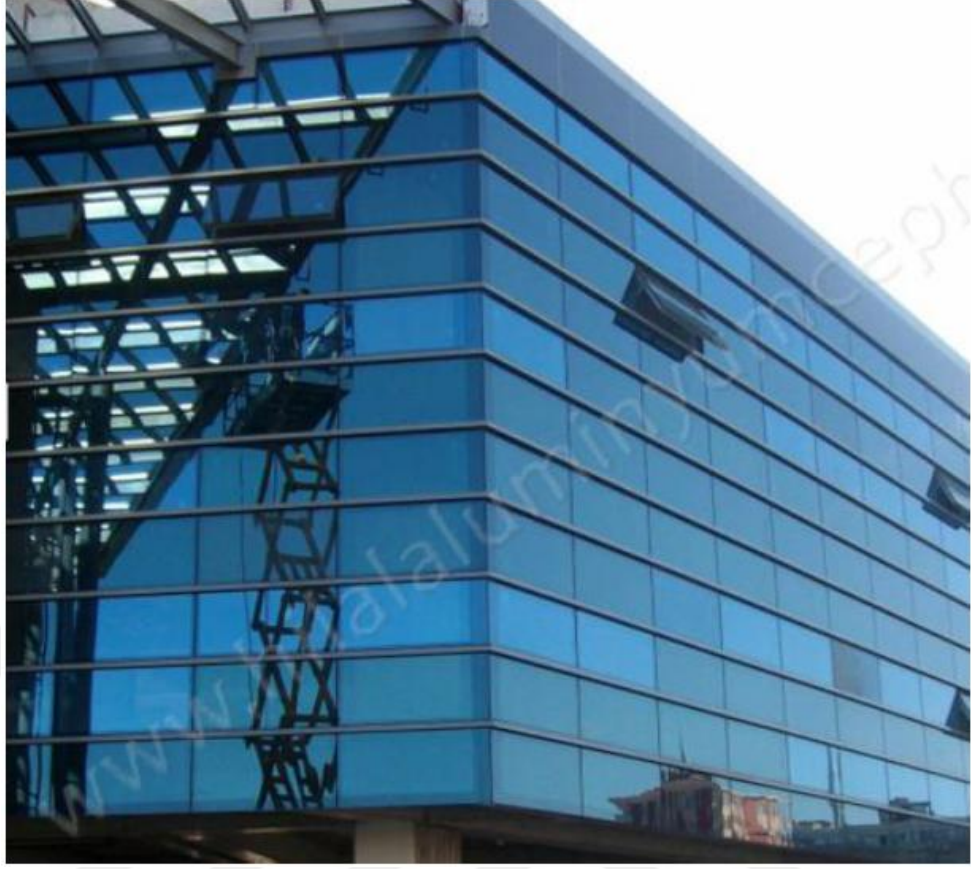
Şekil 12. Yarı Kapaklı Alüminyum Giydirme Cephe Sistemi Örneği ("Yarı kapaklı cephe", 2025)
