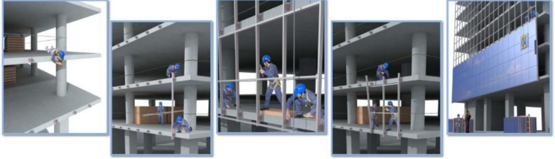
Şekil 4. Çubuk sistem giydirme cephe montaj yöntemi (soldan sağa).
