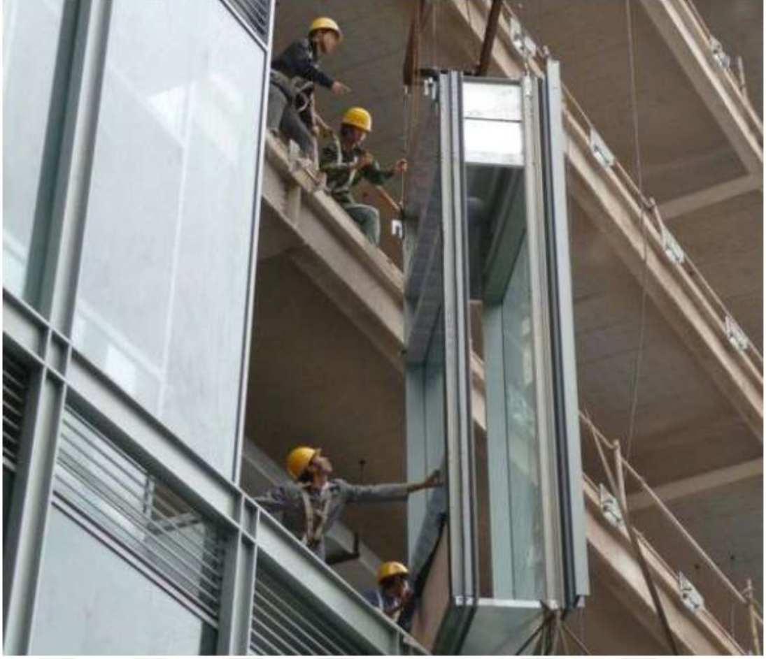
Şekil 5. Ünite sistem cephe montaj örneği ("Curtain walls", 2025)
