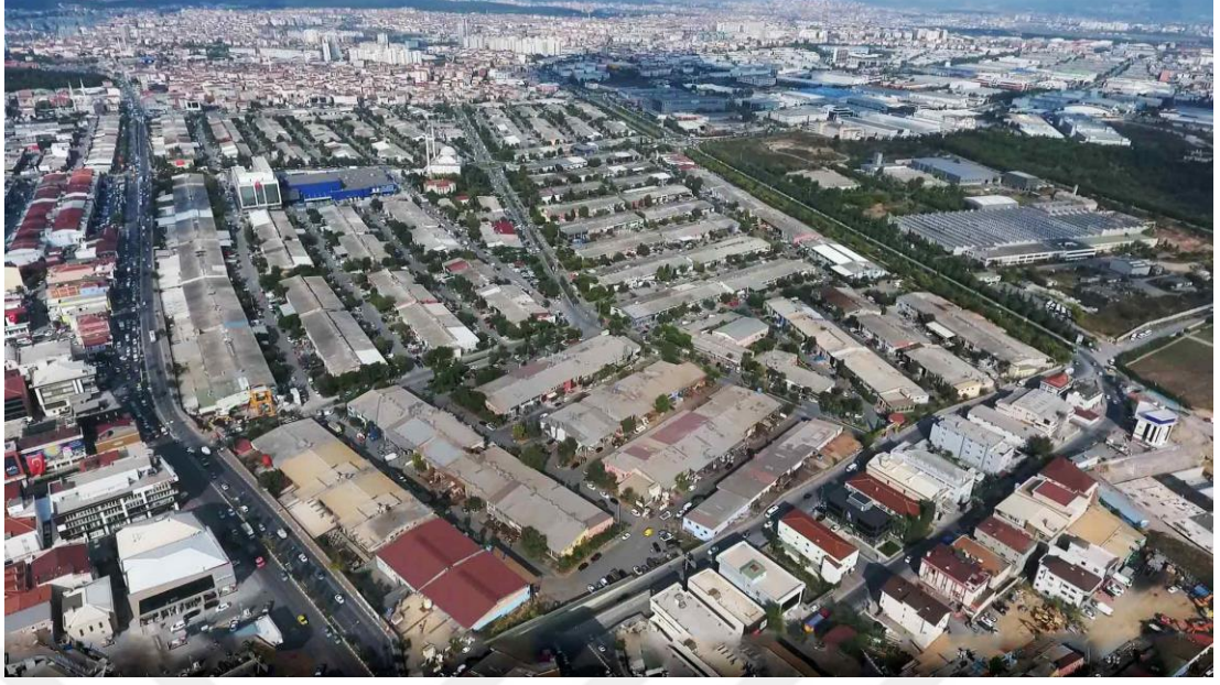
Şekil 5. İMES Sanayi Sitesi Havadan Görünümü
