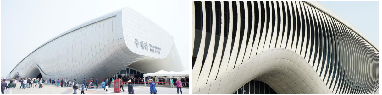
Şekil 4. One Ocean Pavilion'da çevresel uyarılara tepki veren kinetik kabuk sistemi (SOMA Architects, 2012).
