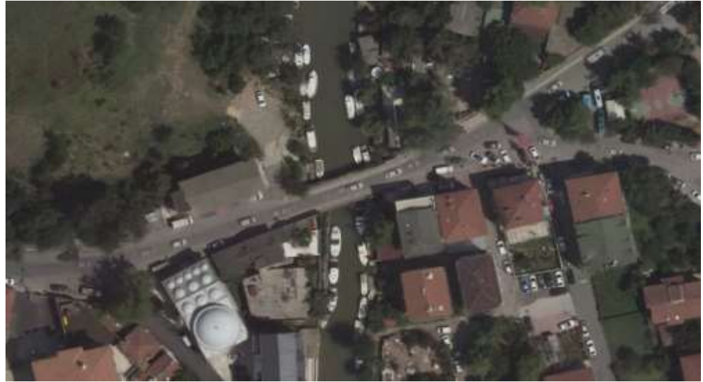
Şekil 19. K3 köprüsü uydu görüntüsü.
