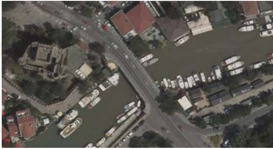
Şekil 17. K1 köprüsü uydu görüntüsü.
