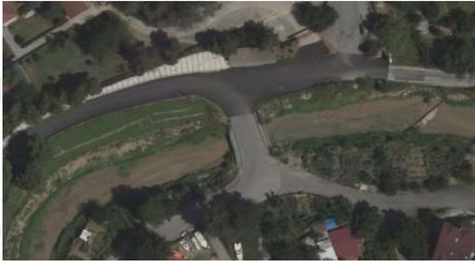
Şekil 23. K7 köprüsü uydu görüntüsü.
