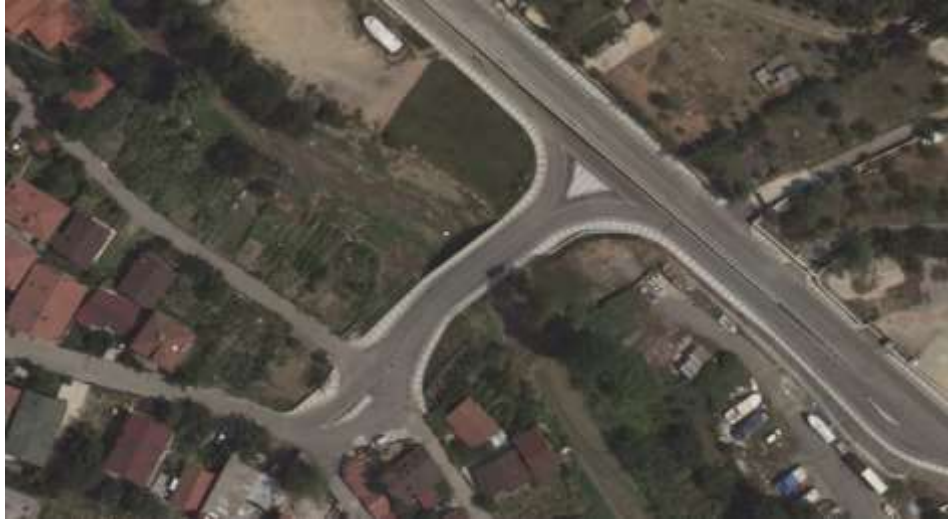
Şekil 22. K6 köprüsü uydu görüntüsü.
