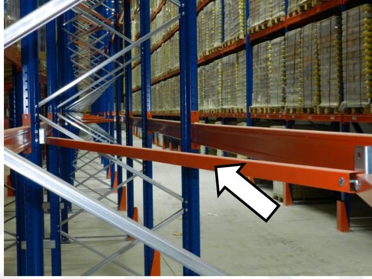
Şekil 31. Yatay deprem gerdirmesi (Asçelik, 2019)
