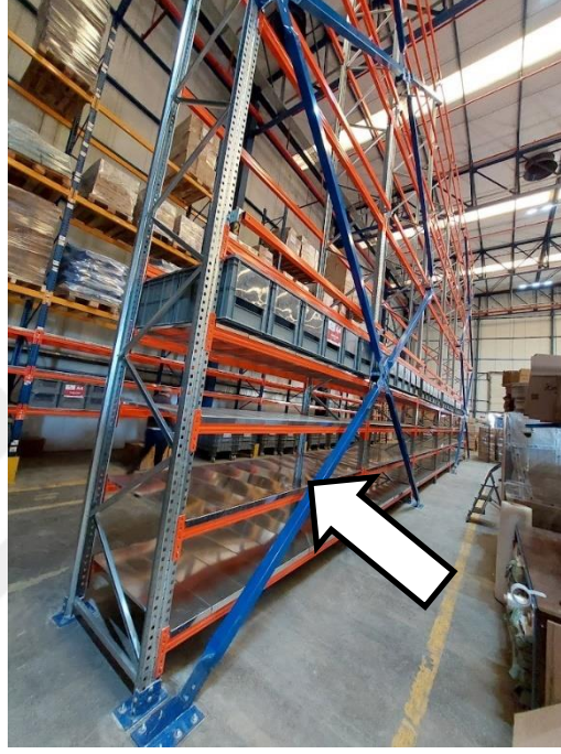
Şekil 33. Düşey deprem gerdirmesi (Asçelik, 2023)
