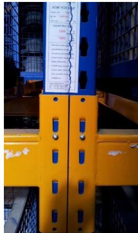
Şekil 29. Travers bağlantı konnektörleri (Standard Raf, 2013)
