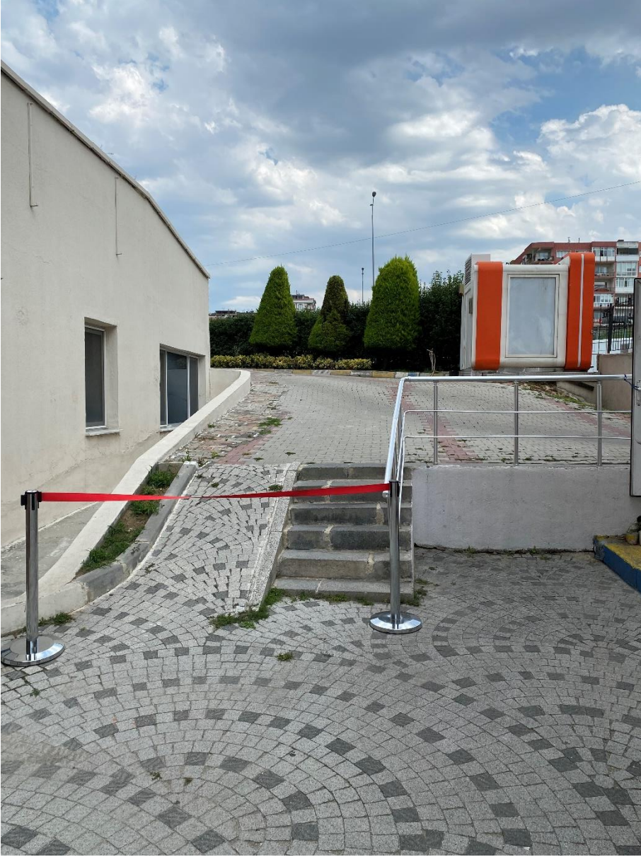
A Blok zemin kat geiř rampası
