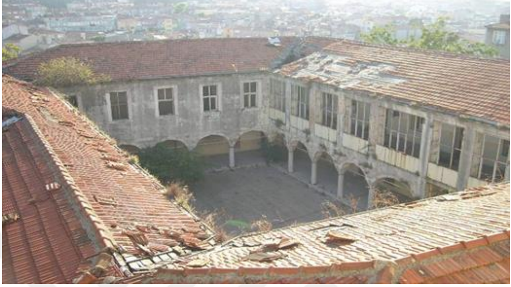
Resim 17. İstanbul Atik Valide Darüşşifası (2019)
