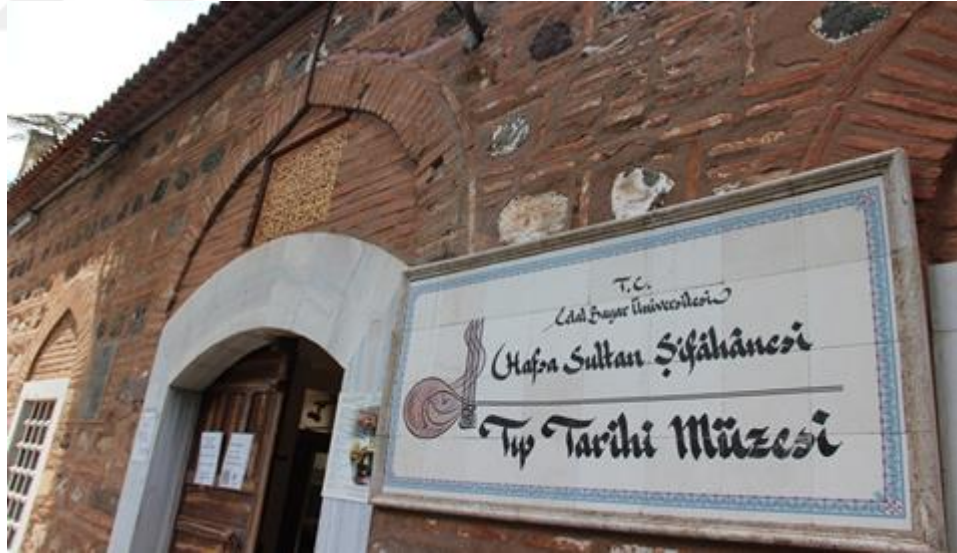
Resim 16. Hafsa Sultan Şifahanesi Kapısı (2021)
