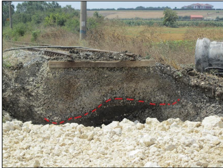
Şekil 8. Eski demiryolu hattı kesitinde balast cebi (Ballast pocket in old railway line cross section)
