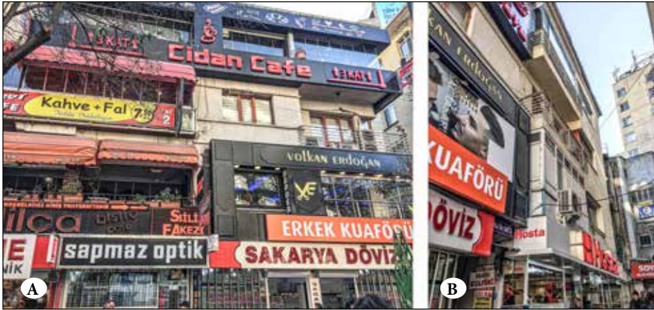
Şekil 7A ve 7B. Paşakay Apartmanı mevcut cephe fotoğrafları. Fotoğraf: Başak Lale, 2018.
