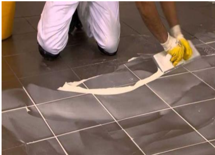
Şekil 13. İmalatı tamamlanmış seramiklere derz malasıyla derzler veriliyor
