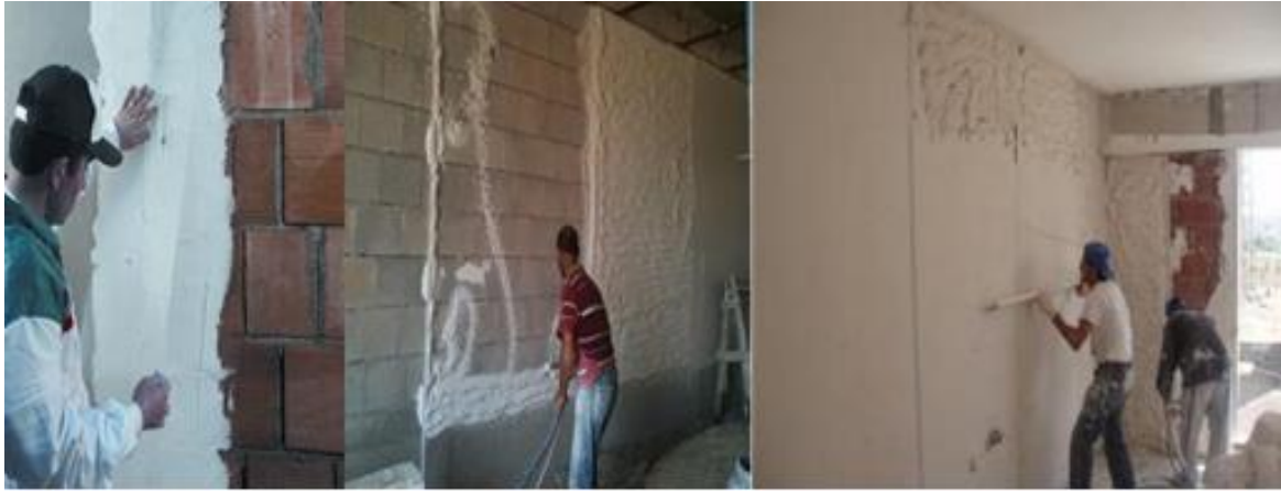
Şekil 5. Terazide alınan anoların brüt beton-tuğla birleşimleri çatlama riskini önlemek için filelenip, terazide ve mastarda olan anolar arası alçı doldurulup, mastarlanıyor
