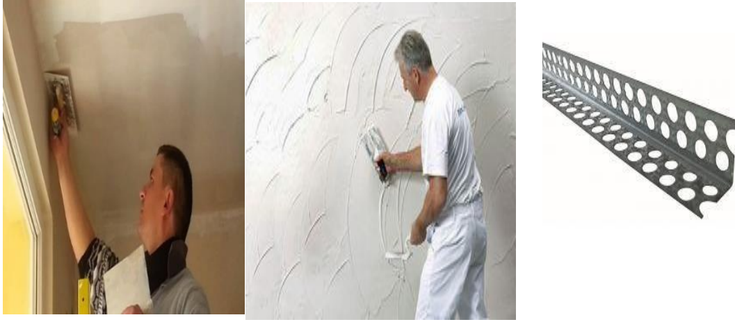
Şekil 7. Tavan-duvar saten alçı ve saten alçı köşebendi
