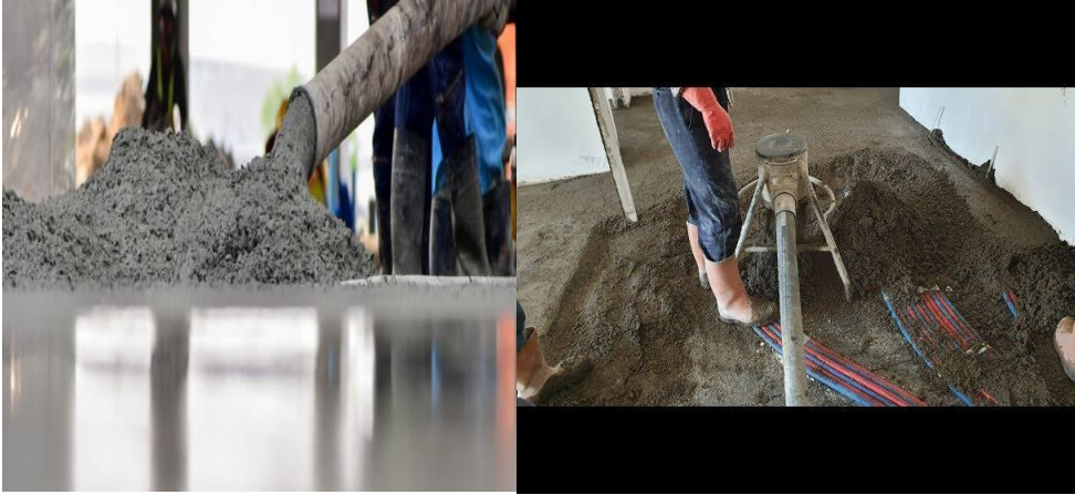
Şekil 14. (+1.00 m) kotuna göre uygulanan şap masterlanıp, yüzey düzgünlüğü için helikopterle tirfilleniyor
