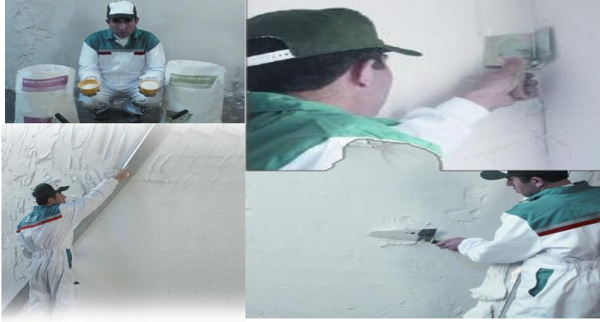
Şekil 6. Karışık alçı hazırlanıp yüzeye uygulanıyor ve köşeler köşe malasıyla düzeltiliyor
