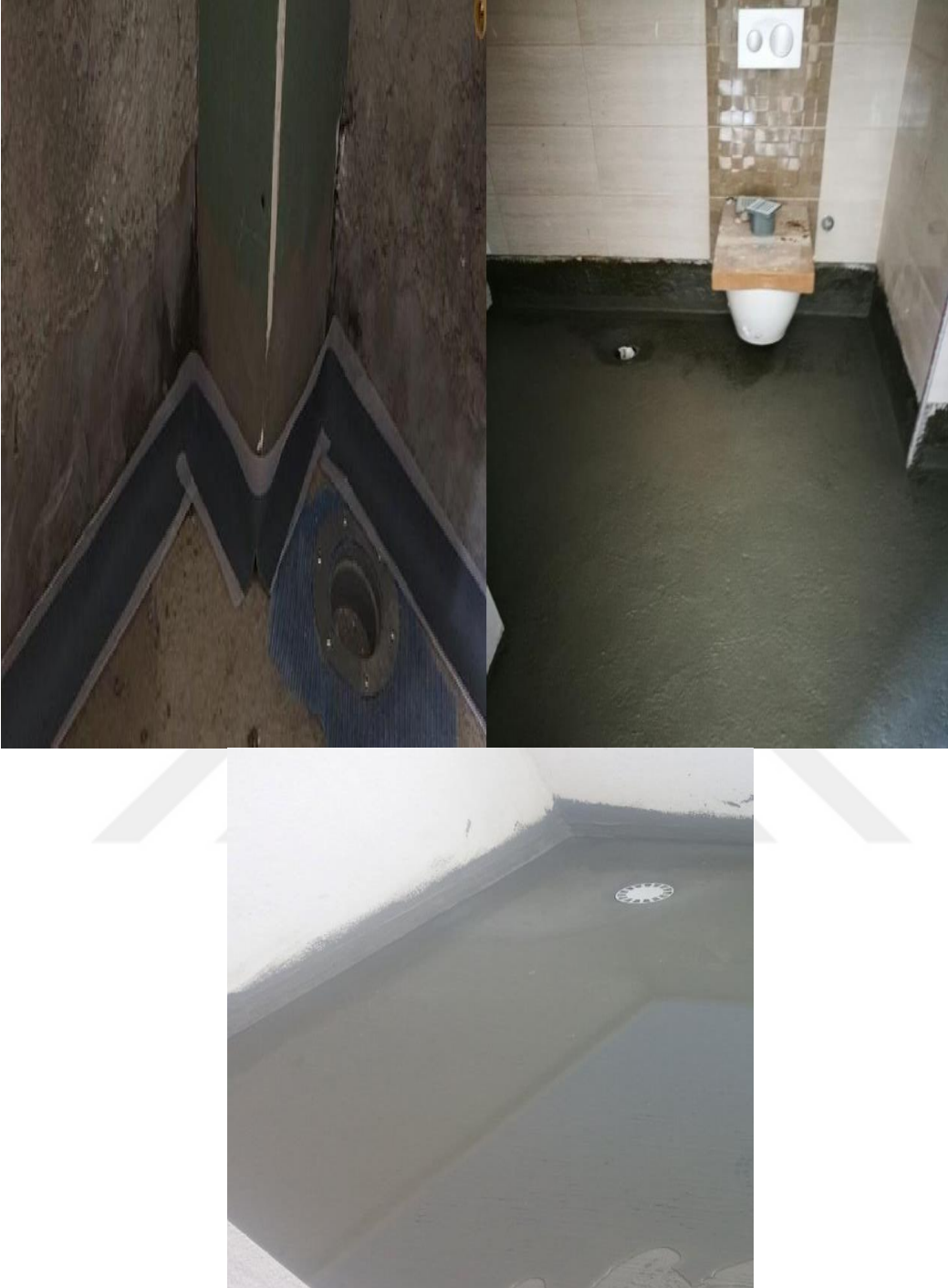
Şekil 27. Elyafli bant, izolasyonu tamamlanmış ıslak hacim ve izolasyon kontrolü yapılan su testi
