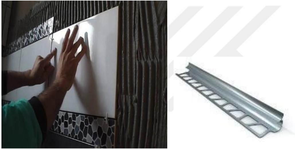
Şekil 12. Örnek bir duvar seramiği imalatı ve seramik köşebendi
