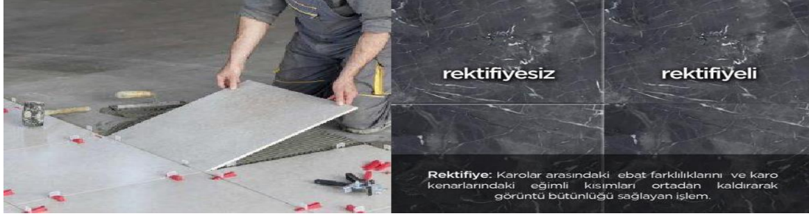
Şekil 11. Taraklanmış seramik yapıştırma harcı, derz artıları ve rektifiyeli seramik
