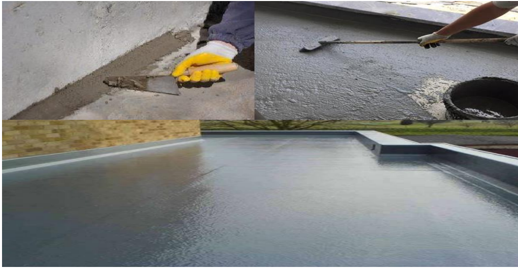
Şekil 26. Pah imalatı (45 derece eğimle kesilmiş kenar) , 1.kat izolasyon ve imalatı tamamlanmış teras şap altı izolasyonu
