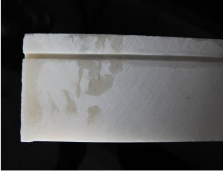
Şekil 28. Fransız doğrama önü denizlik, damar sayısı fazla olan mermer ve mermer (denizlik) damlalığı
