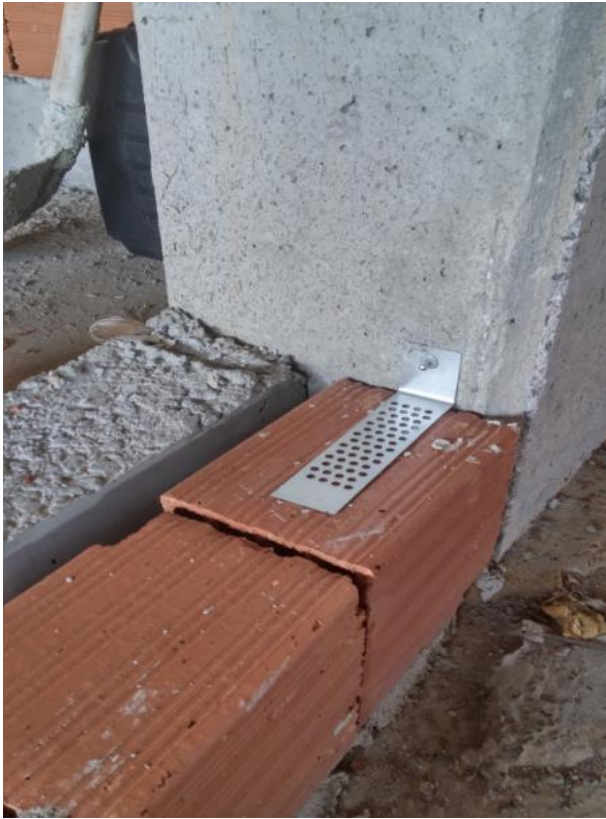
Şekil 4. Tuğla-betonarme ankraj laması
