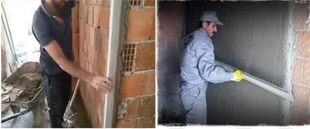
Şekil 9. Yapılan ano masterla yatayda ve düşeyde teraziye alınıp kara sıva imalatı yapılıyor
