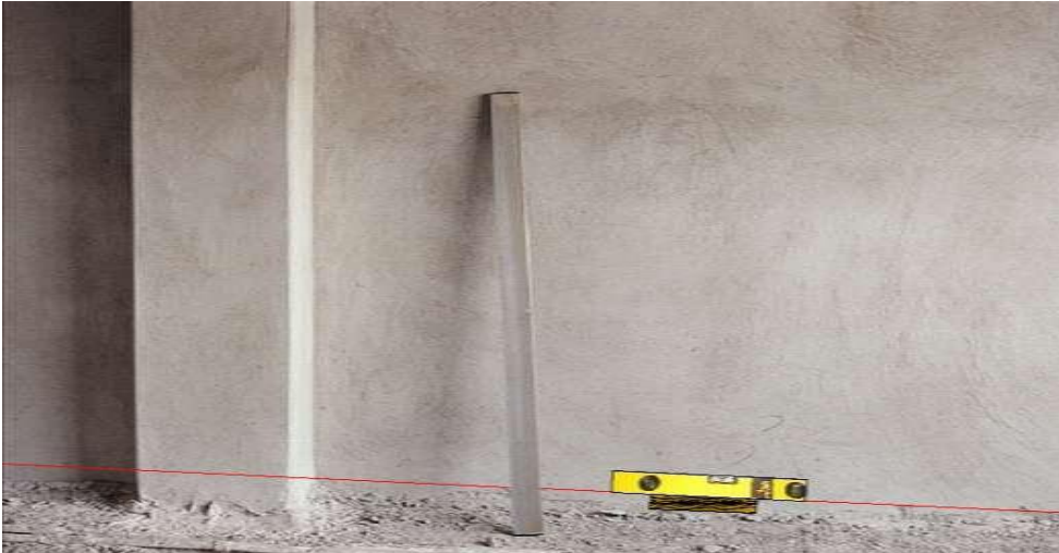
Şekil 15. Şap dökme makinesinden zemine dökülen şap ve eğim anosu(sarı renkli)
