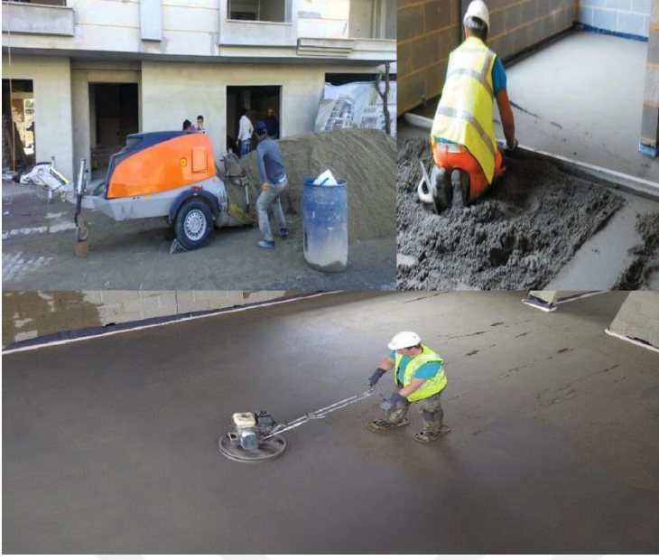
Şekil 14. (+1.00 m) kotuna göre uygulanan şap masterlanıp, yüzey düzgünlüğü için helikopterle tirfilleniyor
