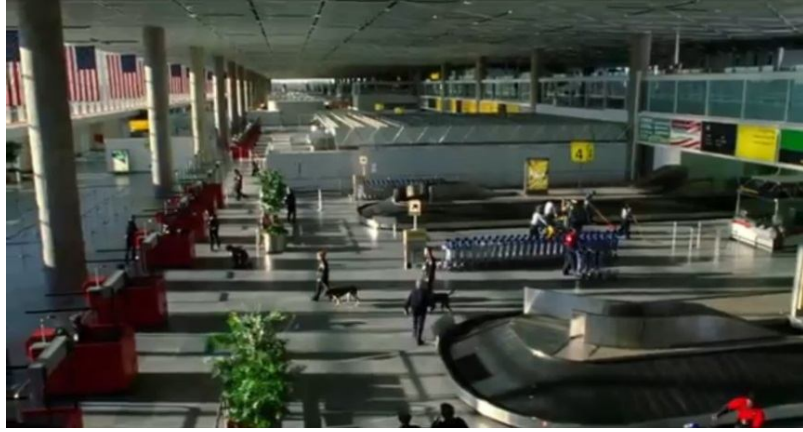
Şekil 3. Terminal binası mimari özellikleri
