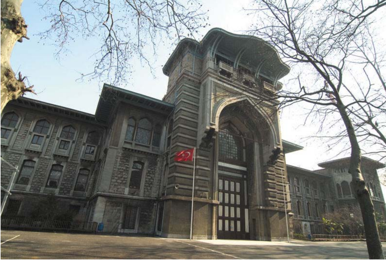
İstanbul'lu Levanten ve Fransız asıllı mimar Alexandre Vallaury tarafından yapılan Düyun-u Umumiye binası (İstanbul Erkek Lisesi, günümüzde İstanbul lisesi)
