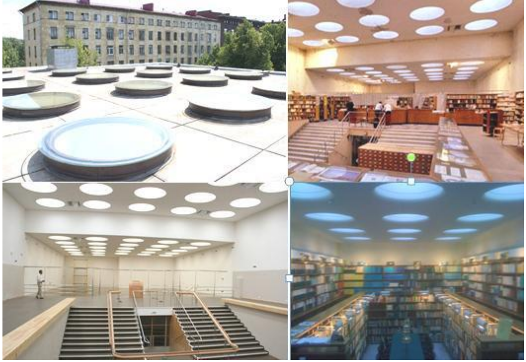
Resim- 21 Çatı Aydınlatma Sistemlerine Örnek Yapılar. (Rusya) 56
