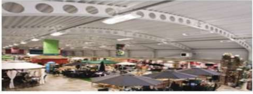
Şekil 11. Çatı uygulamalarında petek kirişler
