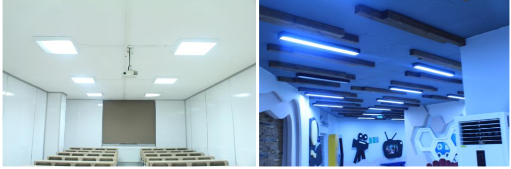
Resim 1. A, B ve C Blok aydınlatma çalışması yapılan bazı alanlar
