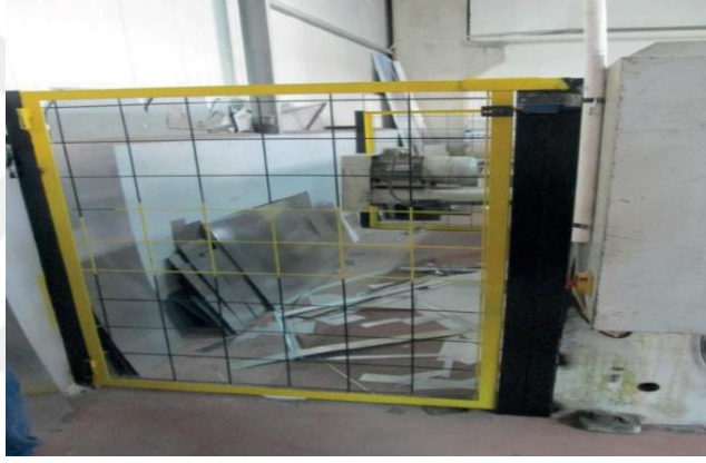
Resim 11. Siviç tertibatlı tel kafesler yapılarak giyotin makasın arka tarafındaki tehlikeli alana geçişin engellenmesi olumlu örnekler
