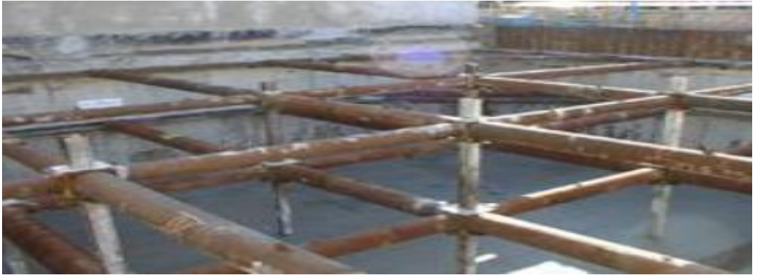
Şekil 24. Boru destekli destekleme sistemi (Çinicioğlu , 2016)
