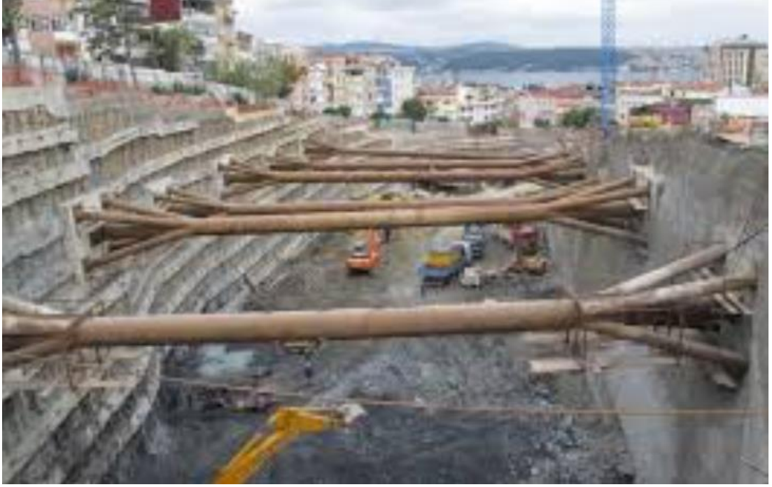
Şekil 3: İç destekli kazı metodu (Ekici,2011)
