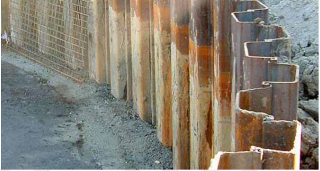
Şekil 6: Palplanş perde sistemleri ("Palplanş Nedir", 2018)
