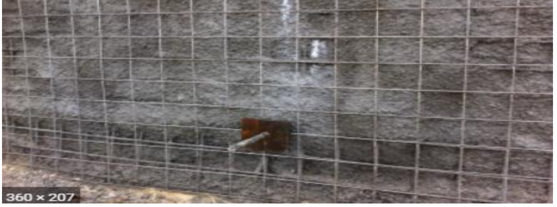
Şekil 25. Zemin çivisi destekleme elemanları ("Derin Kazı Yöntemleri", 2020)
