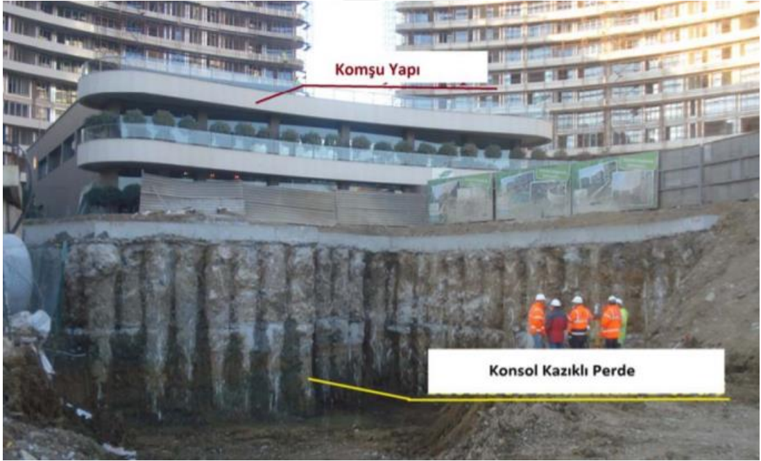
Şekil 2: Konsol iksa perdeleri ile kazı metodu. (Ekici,2011)
