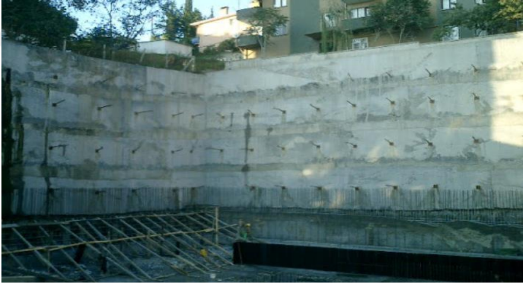
Şekil 17. Ankrajlı diyafram duvar uygulaması ("Geçirimsizlik Perdesi", 2020)
