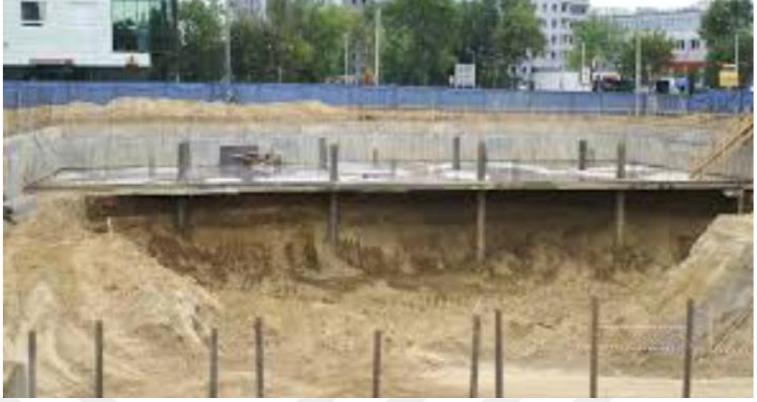
Şekil 5: Top down kazı metodu ("Palplanş Nedir", 2018)
