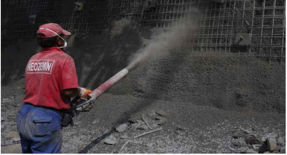
Şekil 15. Püskürtme betonda genel bir uygulama ("Püskürtme Beton", 2020)
