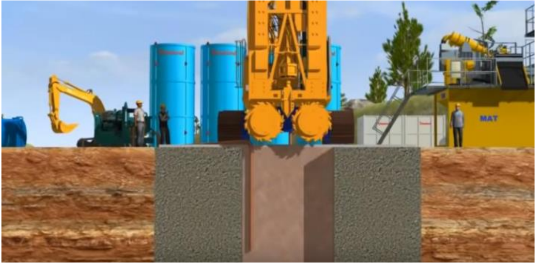
Şekil 16. Diyafram duvarlarda uygulama yöntemi ("Diyafram Duvar Nedir?", 2019)
