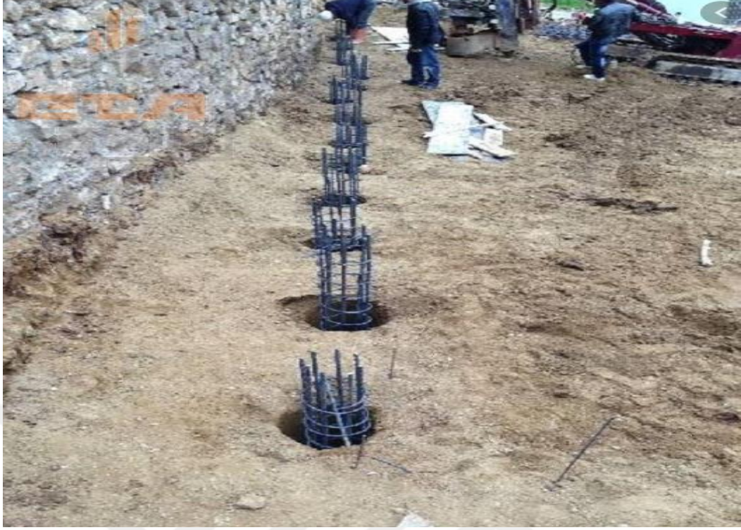
Şekil 13: Mini kazık çalışması ("Mini Kazık", 2020)
