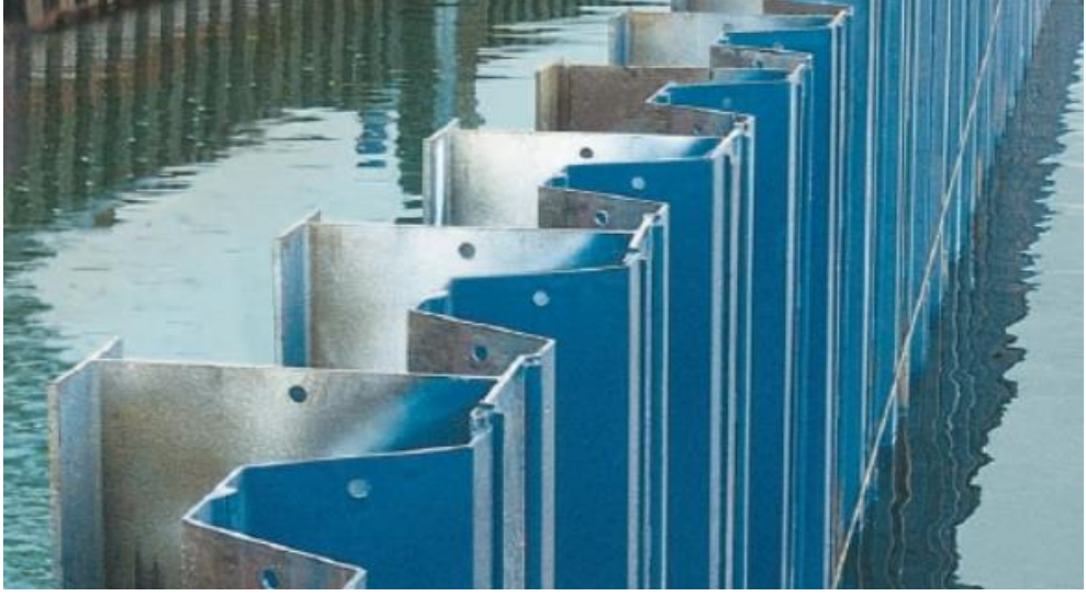
Şekil 7: Kıyılarda palplanş perde sistemleri ("Palplanş Nedir", 2018)
