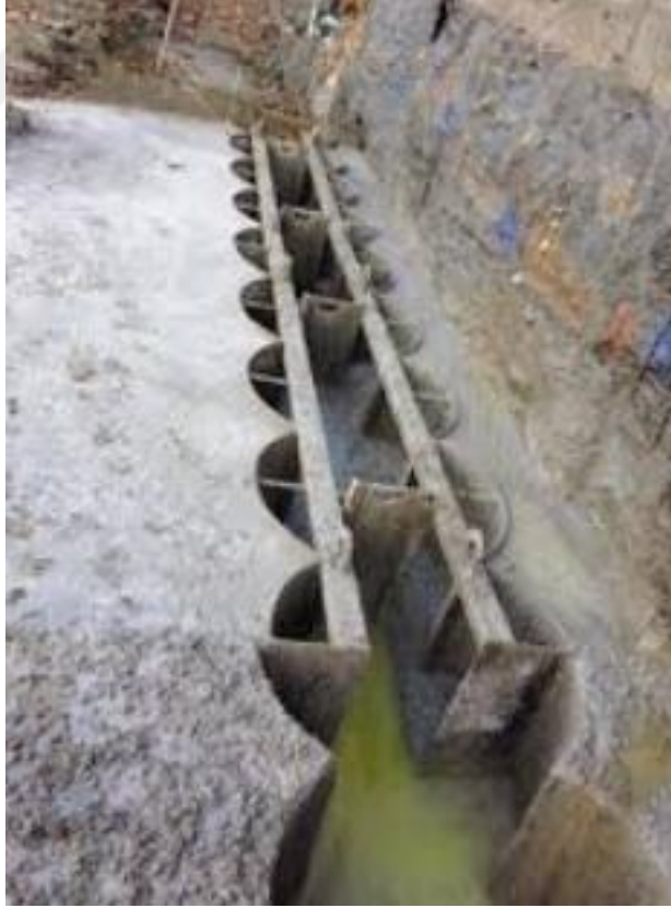
Şekil 11: Bindirme kazıklı perde sistemi ("Geçirimsizlik Perdesi", 2020)
