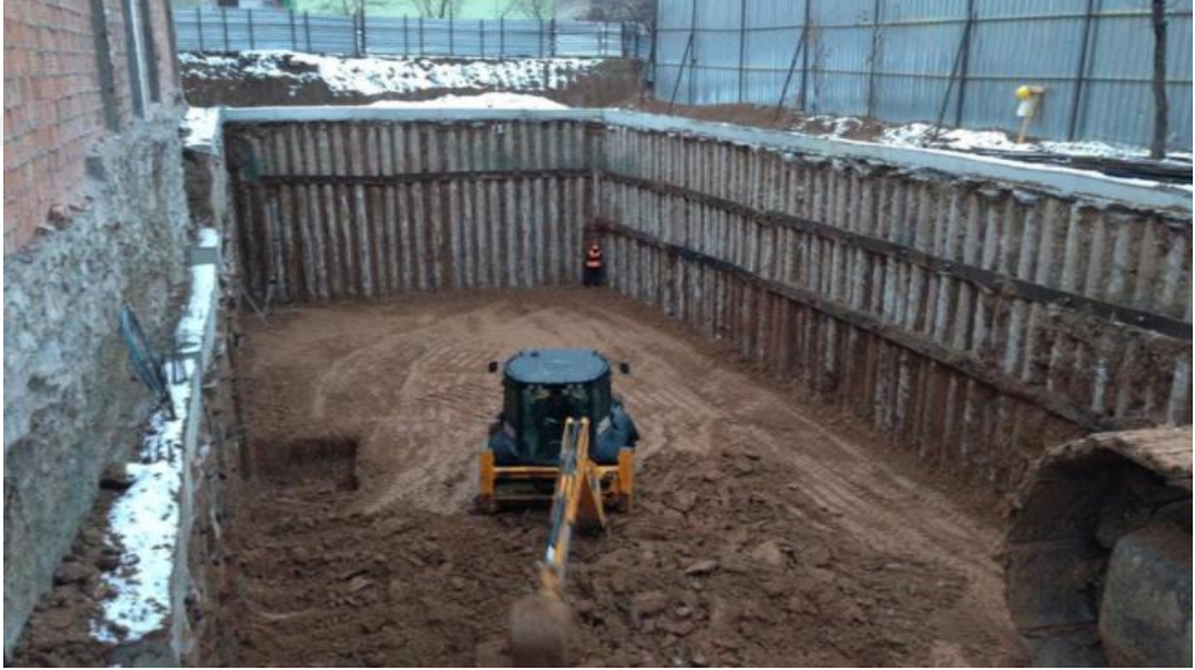
Şekil 12: Mini kazıklı perde sistemi ("Mini Kazık", 2020)
