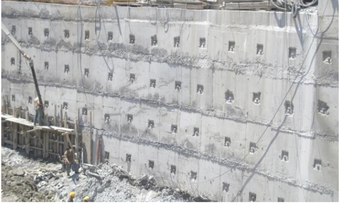
Şekil 4: Ankrajlı kazı metodu ("Kazıklı Perde İmalatı Fore Kazık", 2020)
