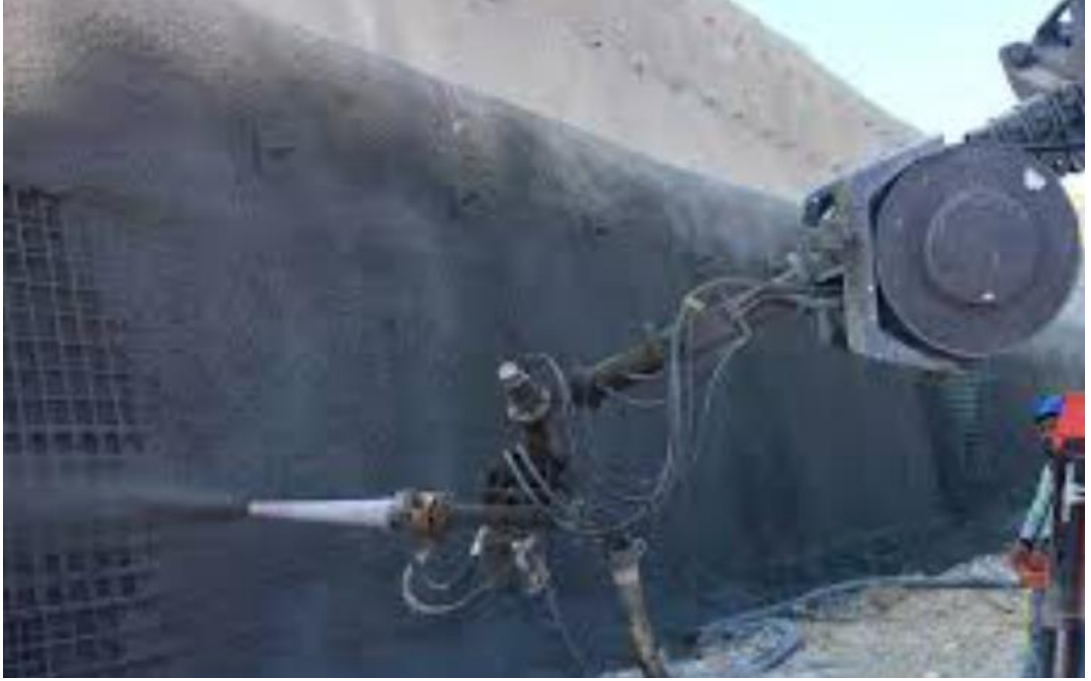
Şekil 14 : Püskürtme beton uygulaması ("Püskürtme Beton", 2019)
