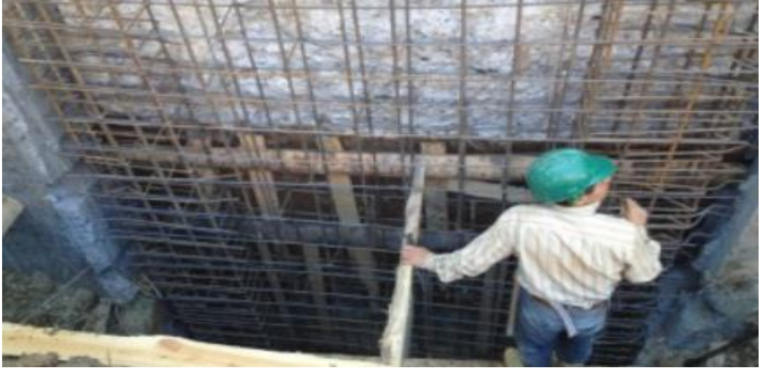
Şekil 21. Kuyu perde donatı hazırlama ("Kuyu Perde", 2020)
