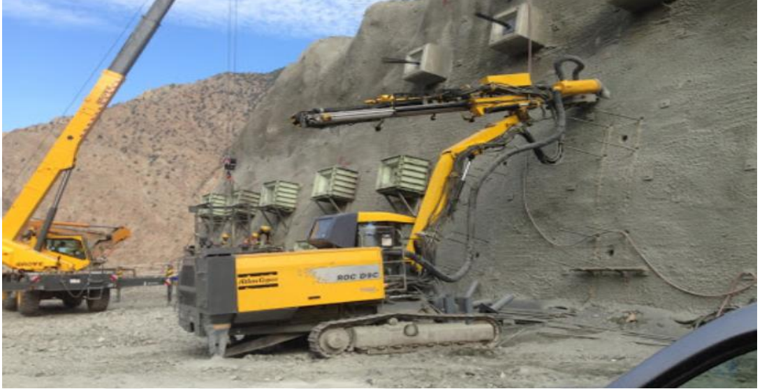
Şekil 47. Ankraj makinası ("Ankraj ve Jet Grout Makinaları", 2020)
