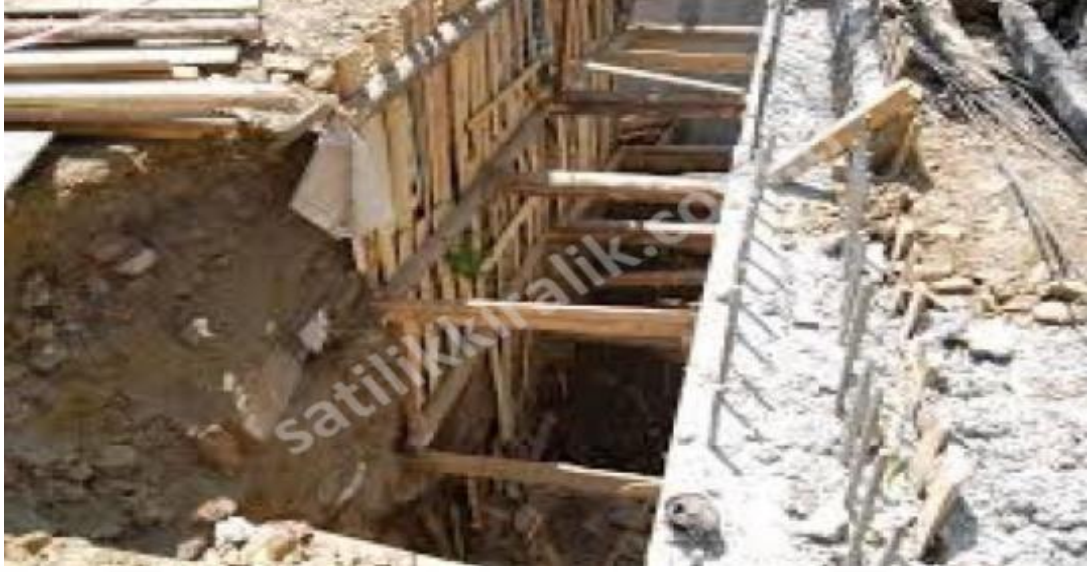
Şekil 20. Kuyu perde kalıbı hazırlama ("Kuyu Perde", 2020)
