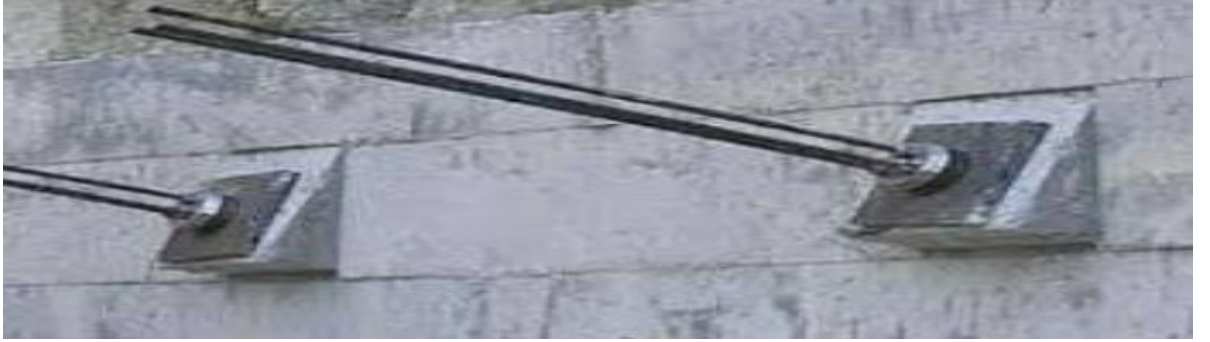
Şekil 22. Gerilmesi yapılmış ankraj örneği (Dadaşbilge, 2018)
