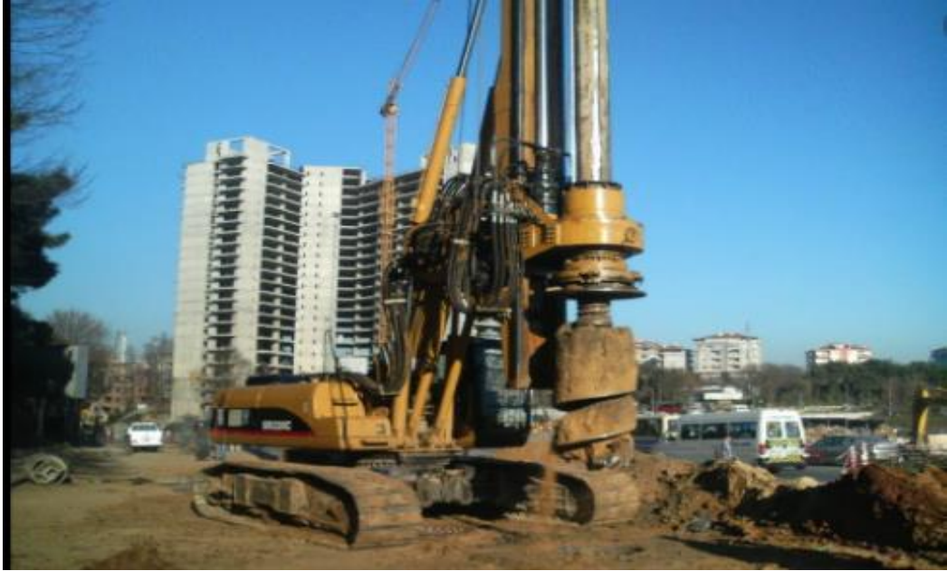
Şekil 8: Fore kazık imalatı ("Neden Yapılır? Fore Kazık", 2016)
