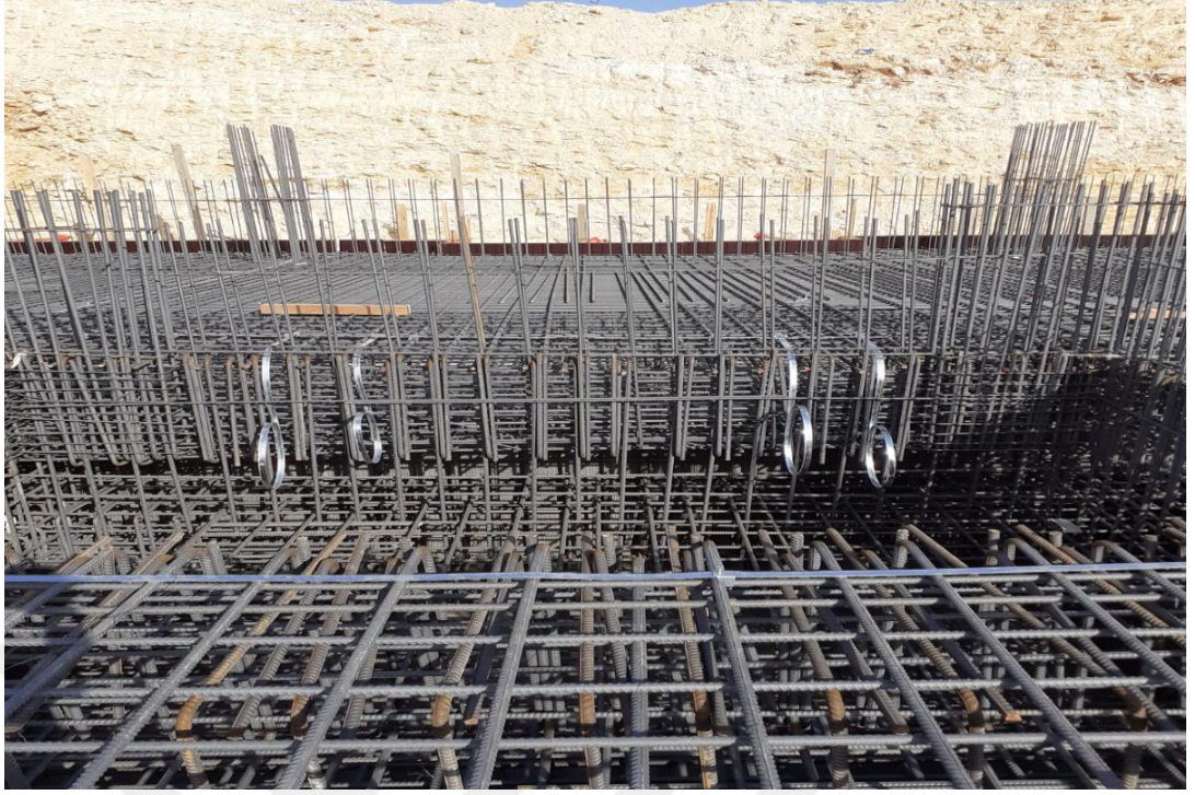
Resim 5. Asansör kuyularında bırakılan galvaniz şerit görseli
