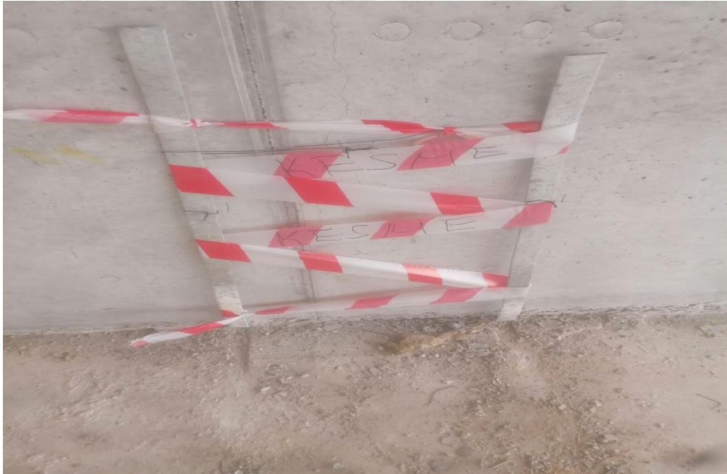
Resim 4. Eş potansiyel dengeleme barası için bırakılan galvaniz şerit görseli
