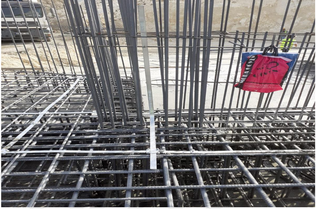
Resim 2. Topraklama bağlantı klemensleri ile bağlantı filizi görseli
