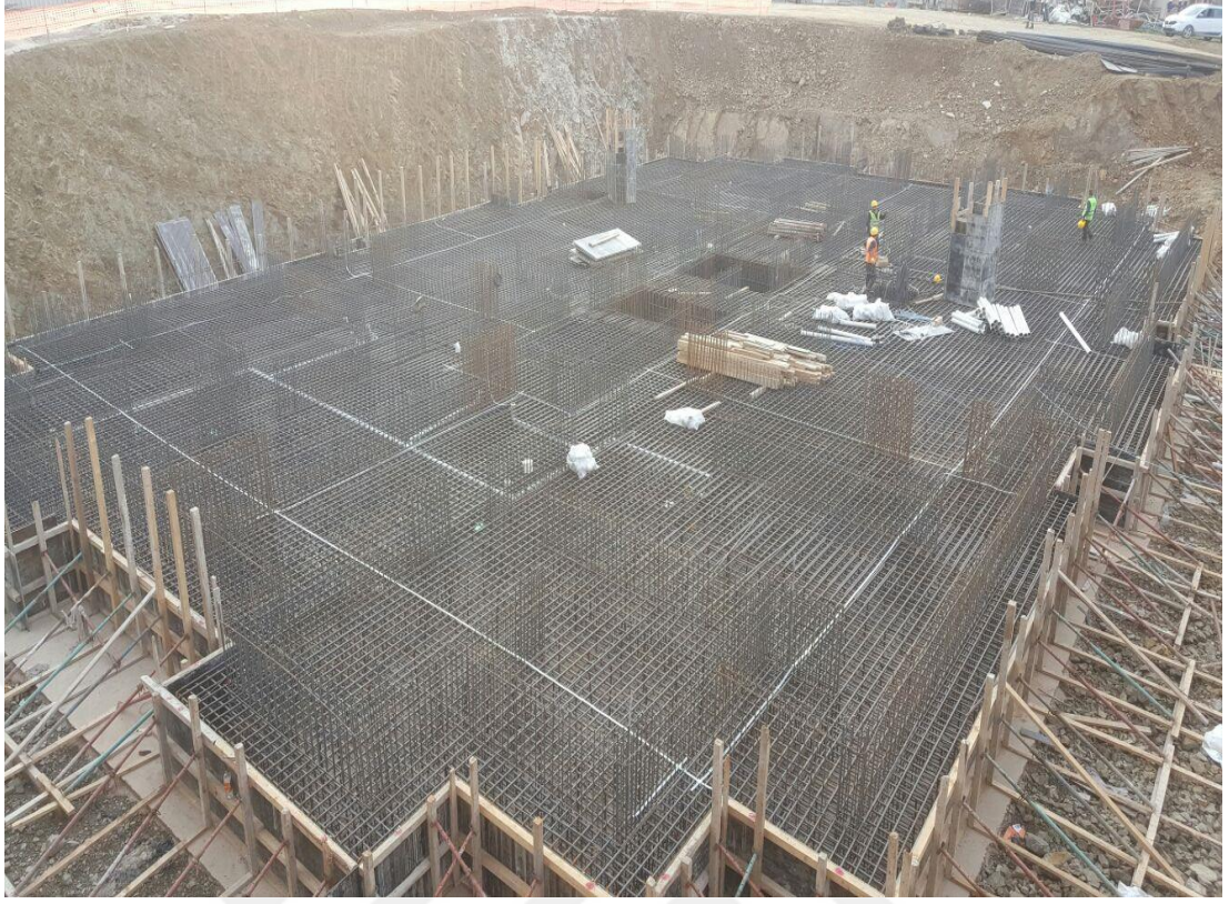
Resim 1. 1. Blok temel topraklama uygulama görseli
