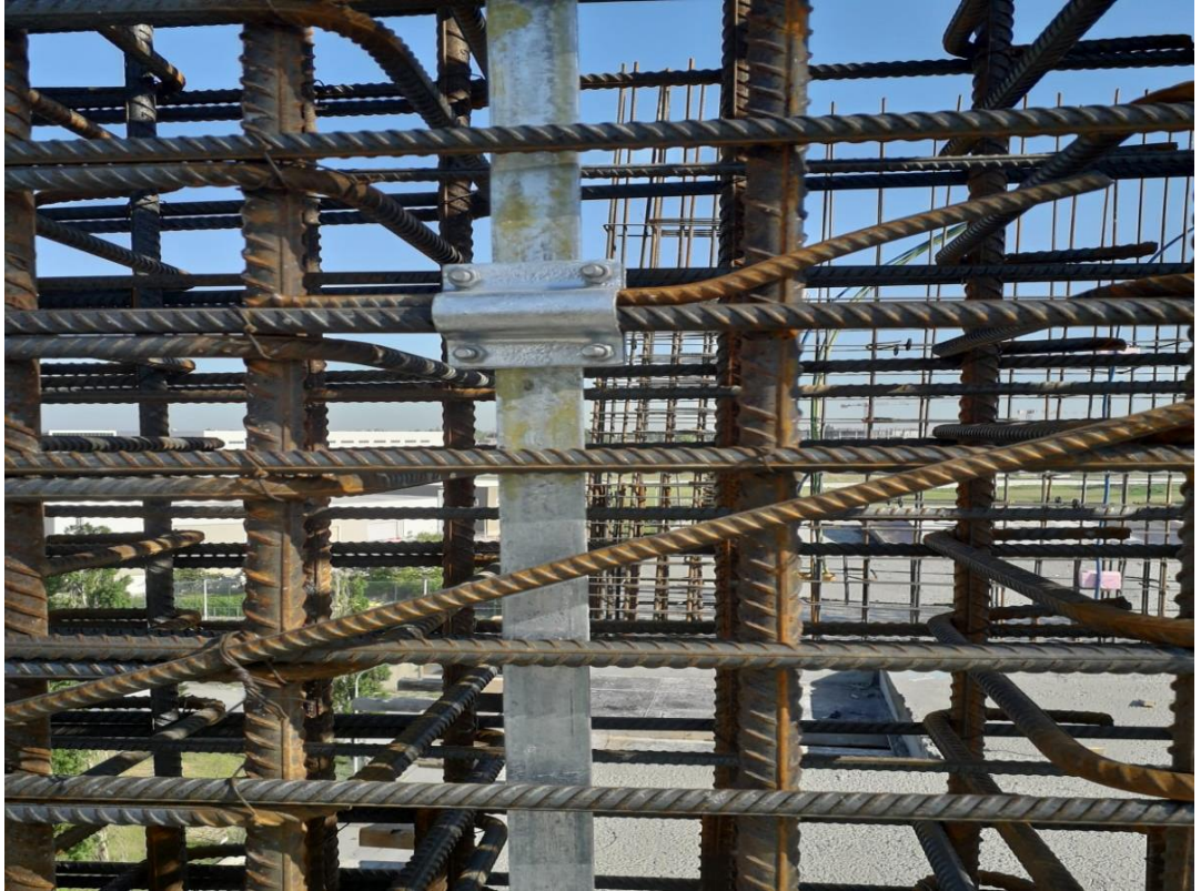
Resim 3. Topraklama bağlantı klemensleri ile kolon demirlerine bağlantı görseli
